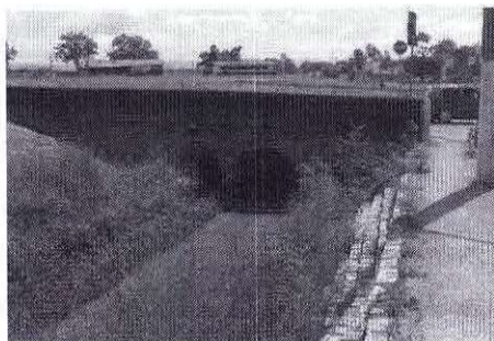
Figura 7: Vista Geral Da Travessia Sob a Avenida Roberto Lee.
