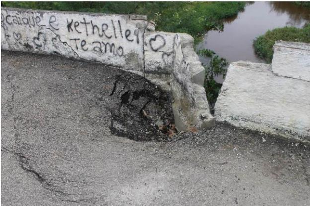
**Foto 12** - Vista Dianteira Da Ruptura Em Uma Das Vigas De Apoio Da Ponte Manoel Bispo De Souza- Ponte Sobre O Rio Iriguaçu.
