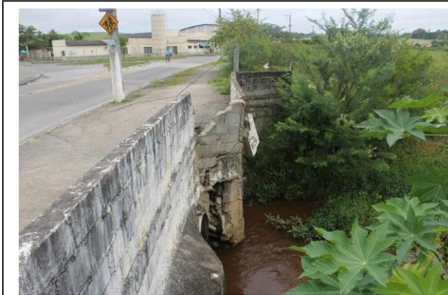
**Foto 11** - Detalhe Da Ruptura Em Uma Das Vigas De Apoio Da Ponte Manoel Bispo De Souza - Ponte Sobre O Rio Iriguaçu.
