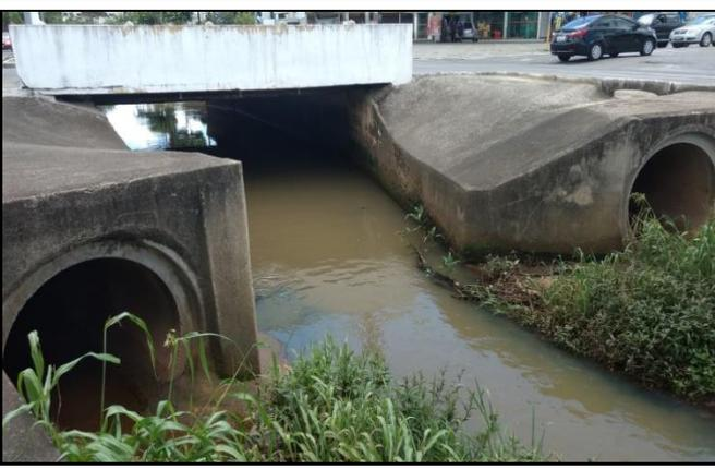
**Foto 54** - Ponte da Rua Dr. Odilon de Souza Miranda Sob o Canal do Ribeirão Manoel Lito na Avenida Brasil. Os Tubos Implantados com o Intuito de Atuarem como "by-pass" se Tornaram uma Interferência, Dificultando o Escoamento no Canal.
