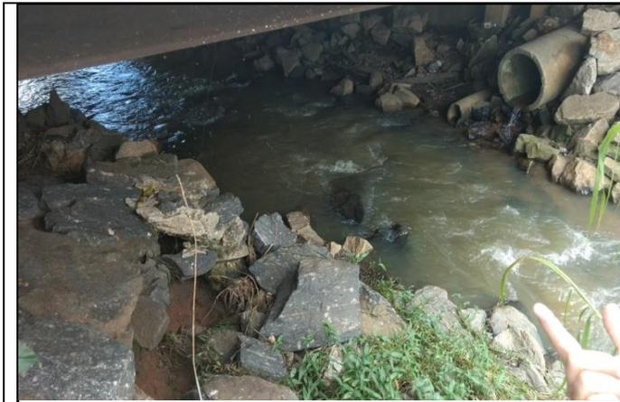
**Foto 55** - Interferência ao Escoamento na Ponte da Rua Pedro de Moura Alcantara. Miranda Sob o Canal do Ribeirão Manoel Lito na Avenida Brasil. O Acúmulo de Pedras e Sedimentos é Comum à Toda Extensão do Canal.
