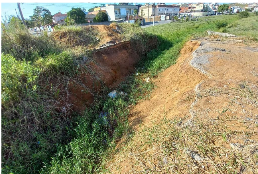
Foto n.º 2 – Aspecto da travessia 01 em observação da jusante para a montante.
