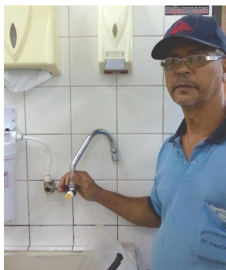
Fotos 15 e 16. Construção de Cisterna em Unidade Escolar, e 17. Instalação de dispositivos redutores de fluxo de vazão de água nas torneiras da Unidade Escolar.
