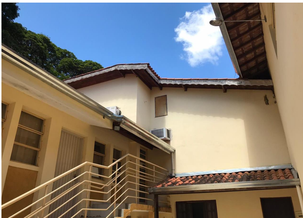
Imagem 09: Área Interna - Pátio Acervo: Dep. de Obras, Viação e Serv. Municipais
