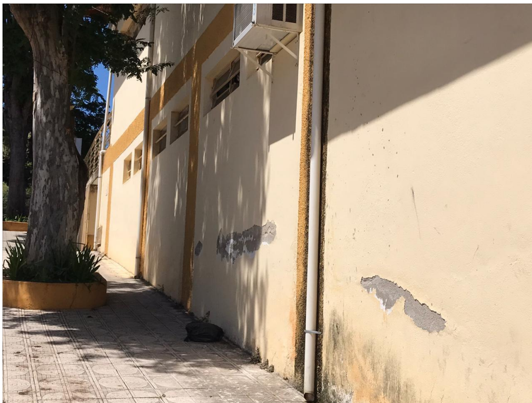
Imagem 06: Área Externa – Rua Sebastião Cunha Acervo: Dep. de Obras, Viação e Serv. Municipais
