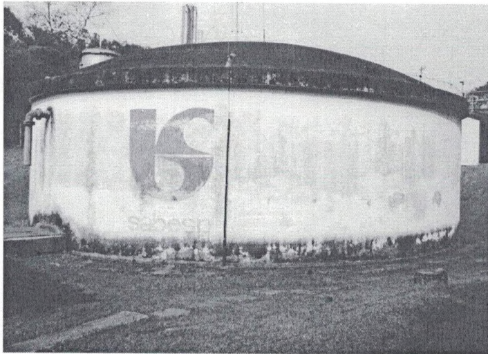
RAP – R1 – Reservatório da ETA
