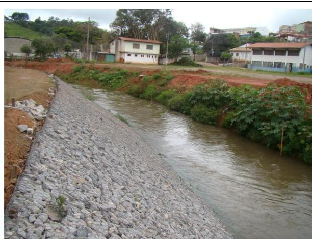
**FOTO 26.** Vista geral, de jusante para montante, de trecho do rio Cachoeira em obras para melhorias do escoamento das águas. Notar proteção da margem direita do rio.
