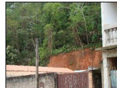
Talude de corte em encosta natural. Notar dimensões do talude de corte e espessura do solo residual.
