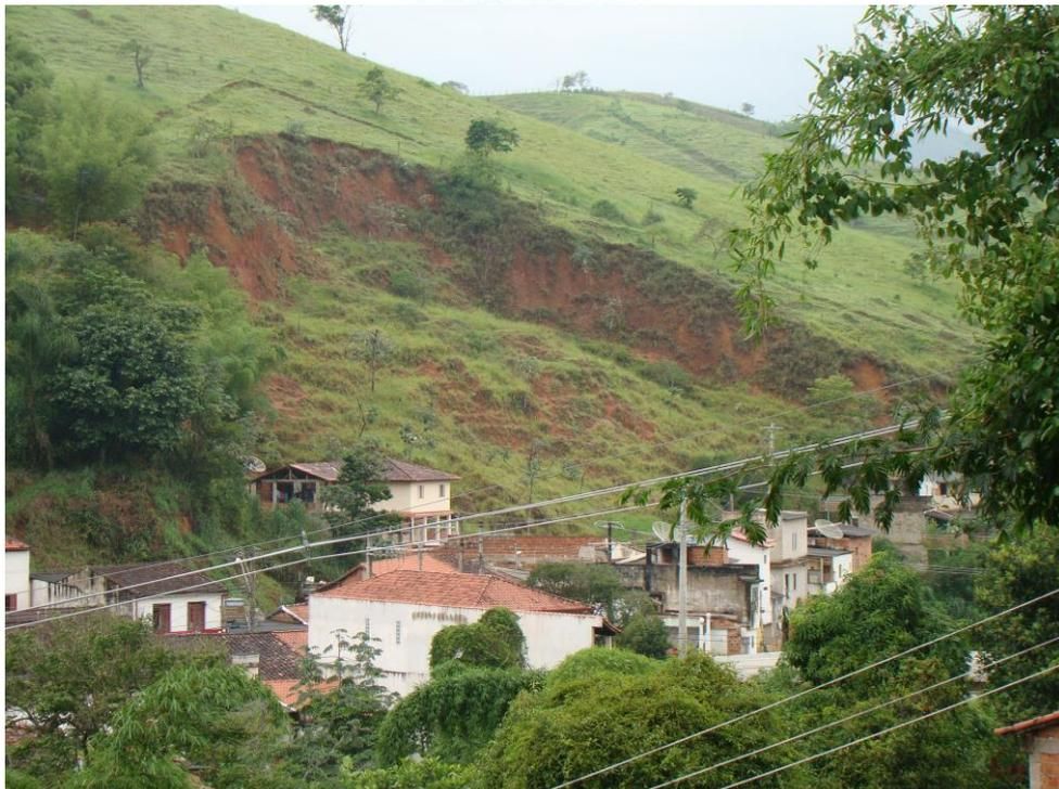
**Figura 6**– Deslizamento circular ou rotacional (Lara – Ctgeo – IPT).
