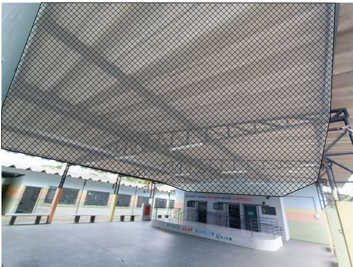
Foto 6. Instalação de rede anti-pássaros no pátio (18x15m)
