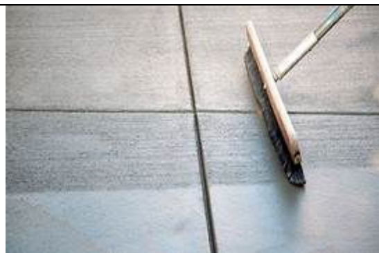
Figura 23 - Piso de Concreto Vassourado
