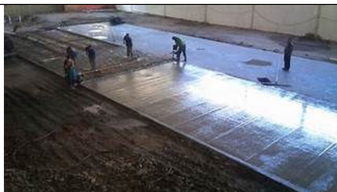
Figura 20 - Vista de Lançamento de Piso de Concreto
