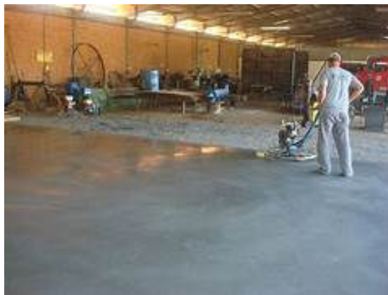
Figura 25 - Piso de Concreto Polido
