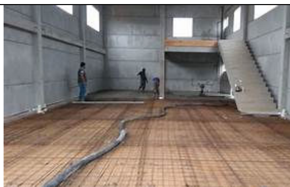
Figura 16 - Início de Concretagem - Sentido Fundos para Frente
