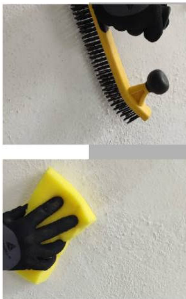
Figura 11 - Preparação de Assentamento
