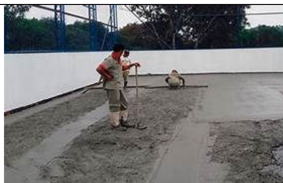
Figura 17 - Vista da Utilização de Guias de Nível
