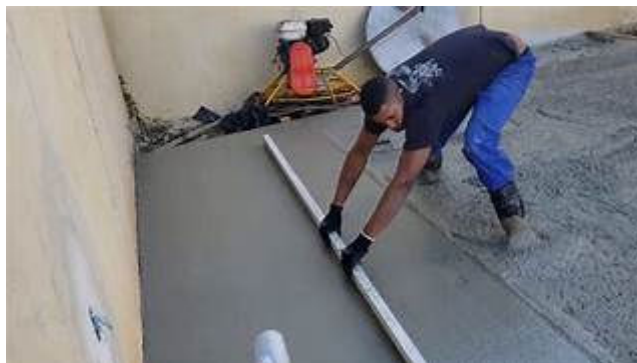
Figura 22 - Sarrafeamento do Concreto
