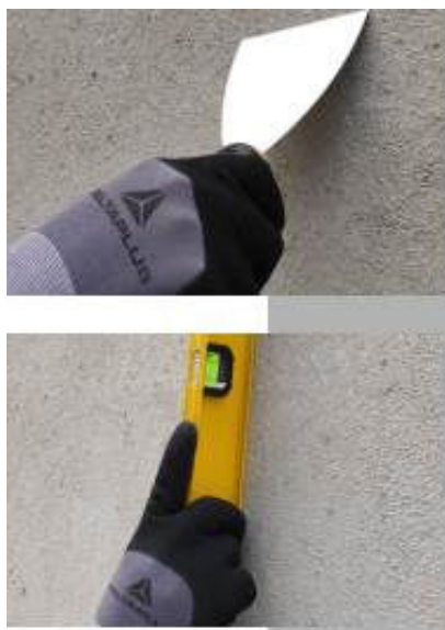
Figura 9 - Verificações Local de Assentamento
