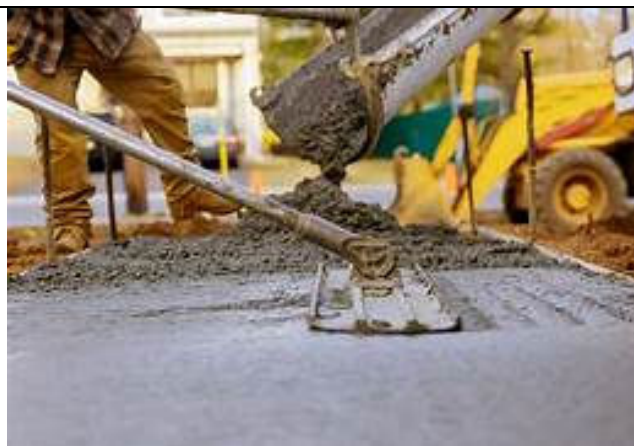
Figura 18 - Acabadora Sarrafeado
