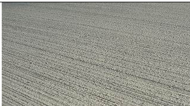
Figura 24 - Piso de Concreto Vassourado
