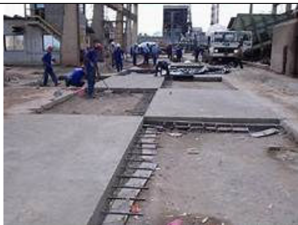
Figura 19 - Divisão de Placas – Execução de Juntas de Trabalhabilidade
