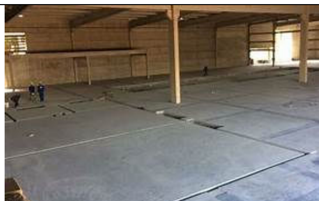
Figura 21 - Vista de Piso Acabado Polido
