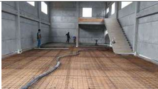
Figura 16 - Início de Concretagem - Sentido Fundos para Frente
