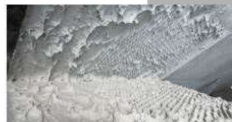
Figura 14 - Compactação e Verificação
