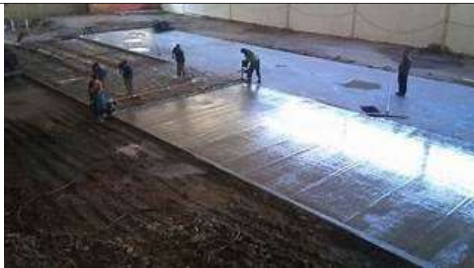
Figura 20 - Vista de Lançamento de Piso de Concreto
