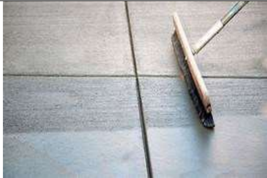
Figura 23 - Piso de Concreto Vasssourado
