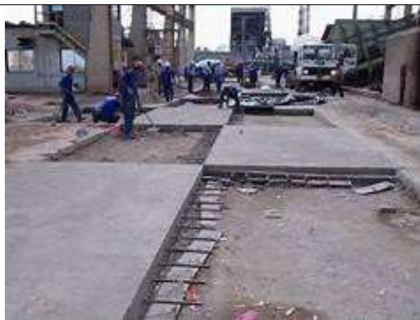
Figura 19 - Divisão de Placas – Execução de Juntas de Trabalhabilidade
