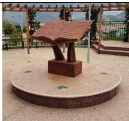
Figura 67 - Exemplo de Instalação da Luminária de Piso para Iluminação da Estátua
