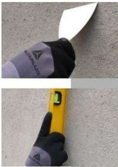
Figura 9 - Verificações Local de Assentamento
