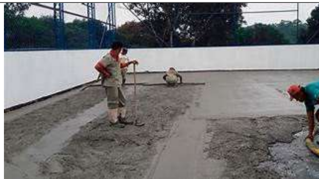
Figura 17 - Vista da Utilização de Guias de Nível
