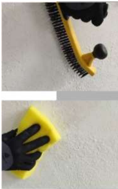
Figura 11 - Preparação de Assentamento
