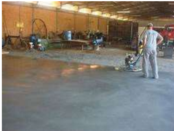
Figura 25 - Piso de Concreto Polido
