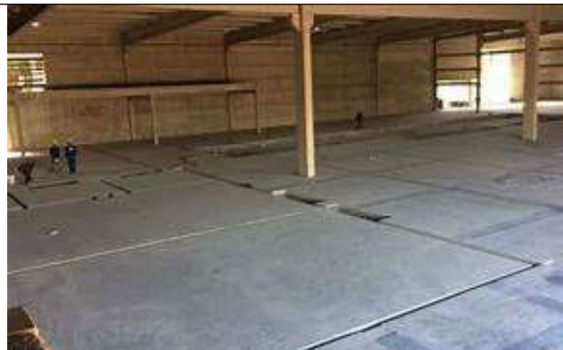
Figura 21 - Vista de Piso Acabado Polido
