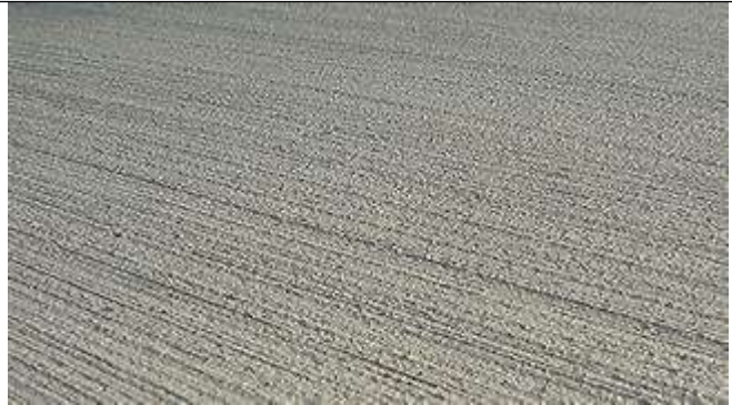
Figura 24 - Piso de Concreto Vasssourado
