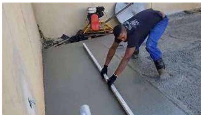
Figura 22 - Sarrafeamento do Concreto
