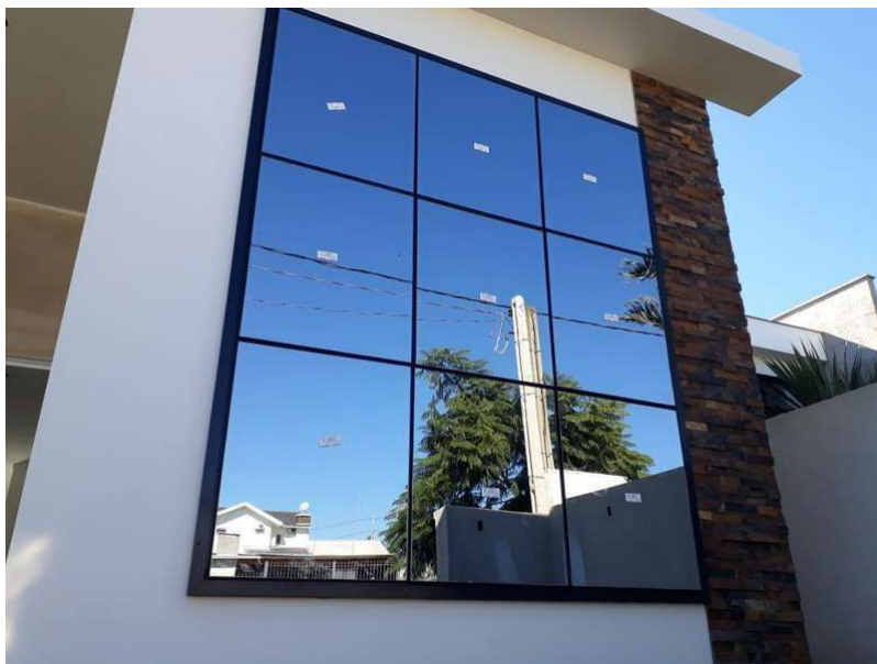
Figura 8 - Pele de Vidro Tipo Grazing Fixação Externa
