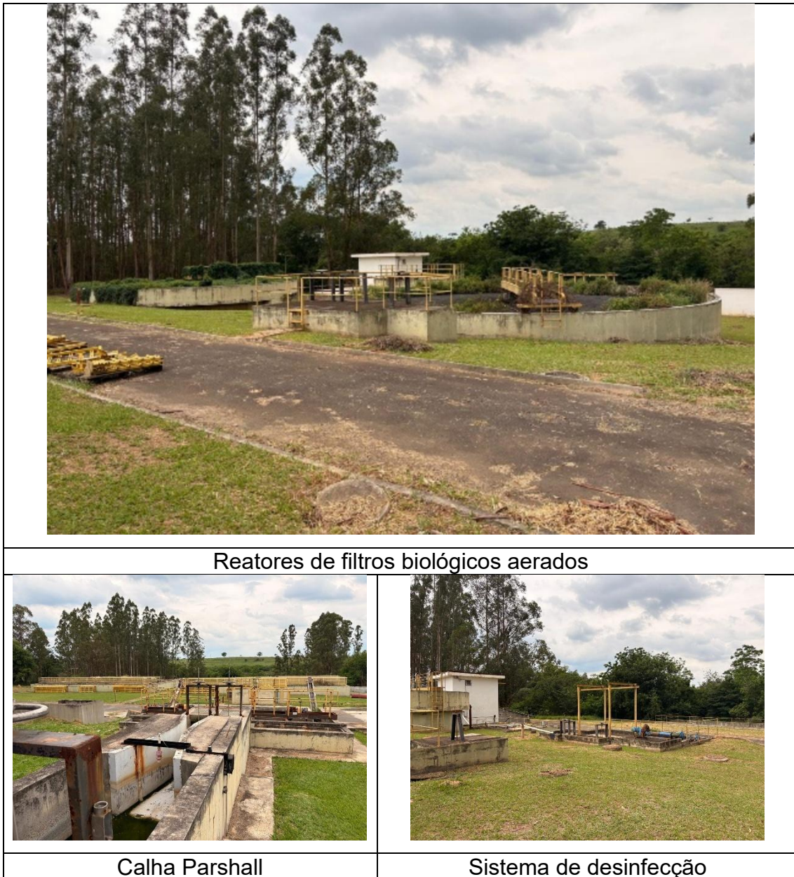
Figura 18. Estação de Tratamento de Esgoto Xyko (ETE Xyko), Porto Feliz/SP.
