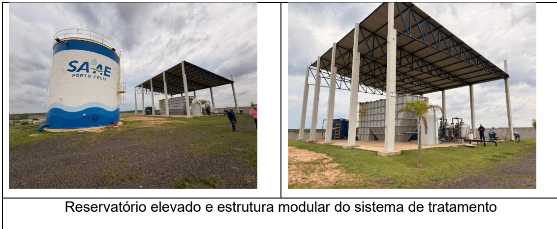
Figura 12. Estação de Tratamento de Água Compacta (ETA Compacta) – Unidade de Produção de Água Tratada, Porto Feliz/SP.
