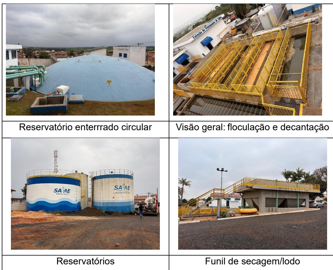
Figura 11. Vista geral da Estação de Tratamento de Água Central de Porto Feliz/SP.
