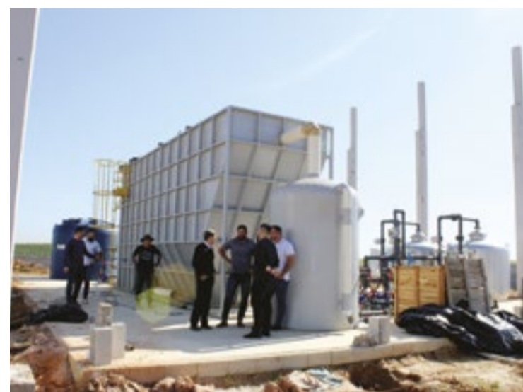
Estação de tratamento de água segue em obras em Porto Feliz
