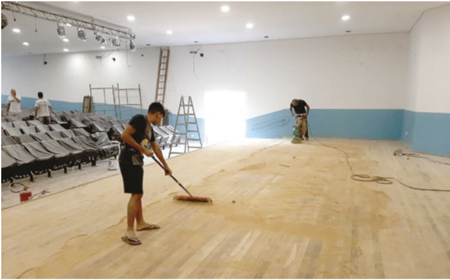
Obras no Espaço Cultural Olair Coan, no bairro Água Branca, em Porto Feliz; espaço recebeu nova pintura, poltronas e iluminação
