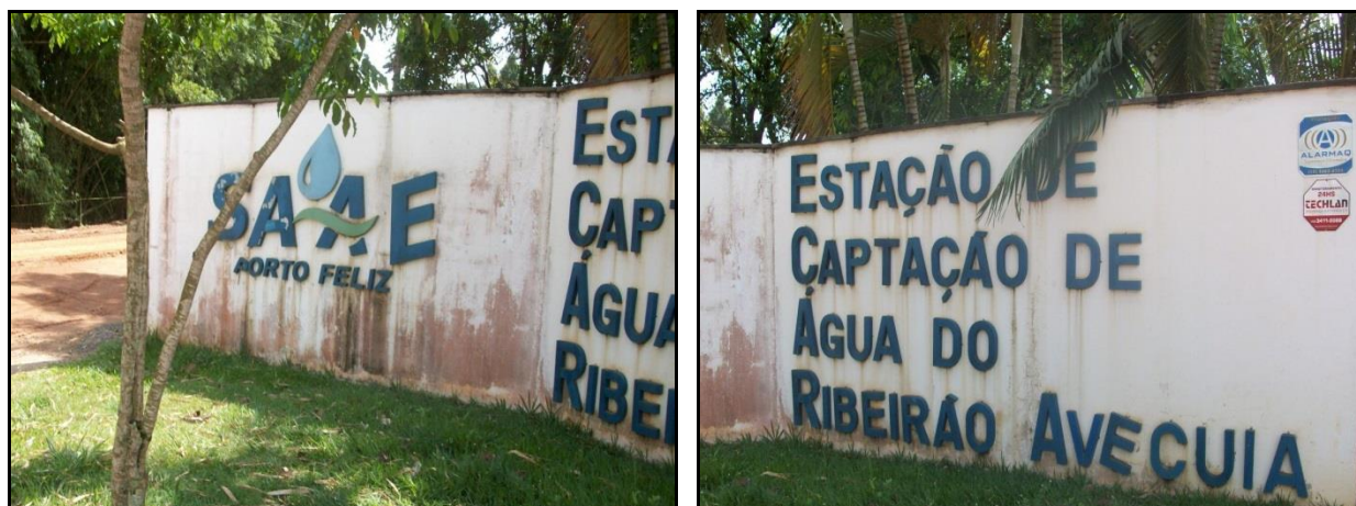
Figura 46 - Vista da Entrada da Estação de Captação de Água do SAAE.
