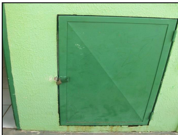
Figura 37 - Lado externo da unidade de saúde – local para armazenamento dos resíduos de saúde.
