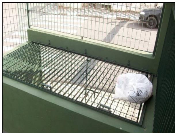
Figura 38 - Vista interna do local para acondicionamento dos RSS.
