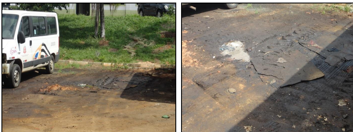
Figura 115 – Óleo lubrificante descartado inadequadamente.
