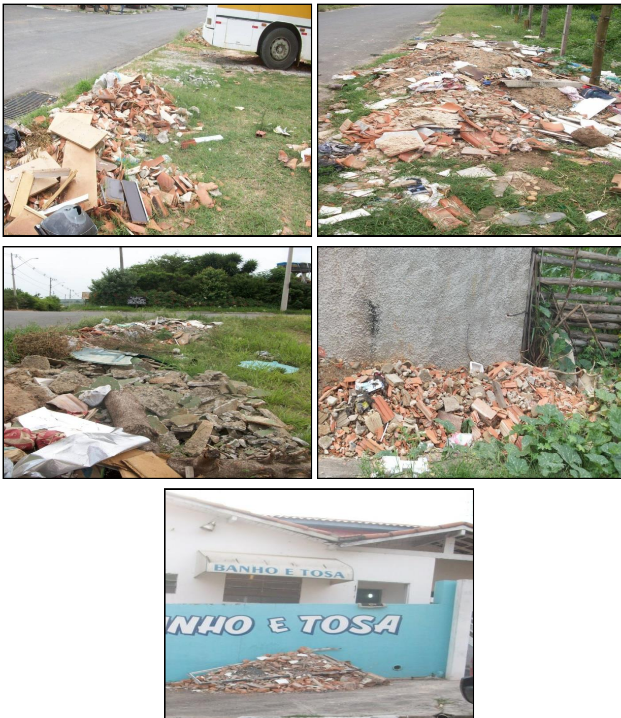
Figura 41 - Acondicionamento inadequado de RCC.
