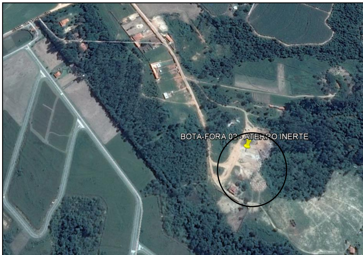
Figura 114 – Bota fora localizado na Estrada Volta do Poço.
