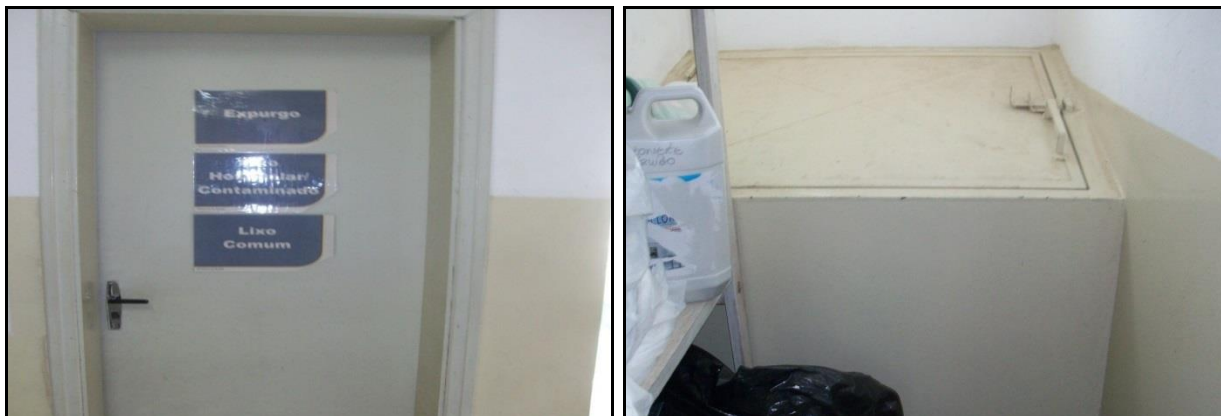
Figura 36 - Sala para acondicionamento dos RSS e local para armazenamento dos resíduos (o acesso para a retirada dos resíduos é pelo lado externo da unidade)
