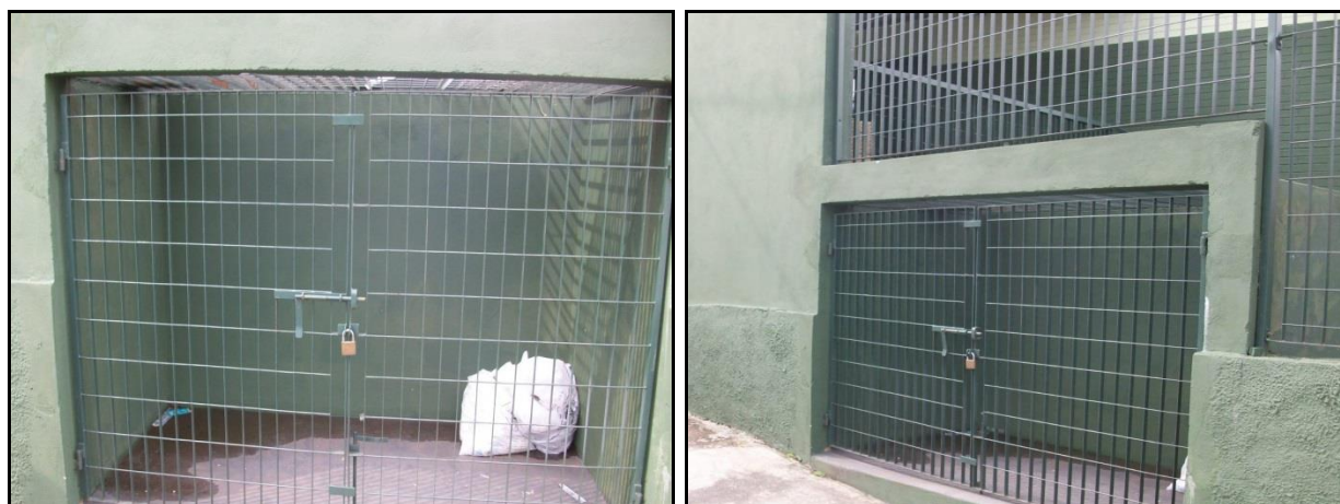
Figura 39 - Vista externa da unidade - local para acondicionamento dos RSS.
