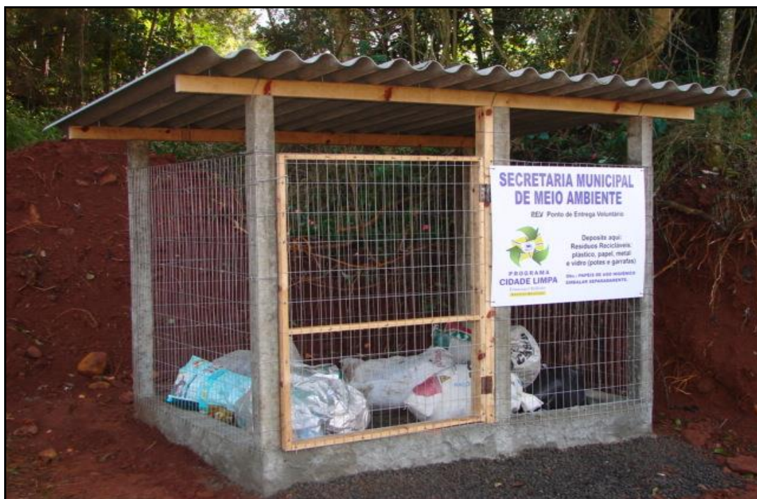
Figura 130 - Modelo de PEV para acondicionamento dos resíduos recicláveis e rejeitos na área rural. Fonte: AMBIENTAL COSTA OESTE (2016).
