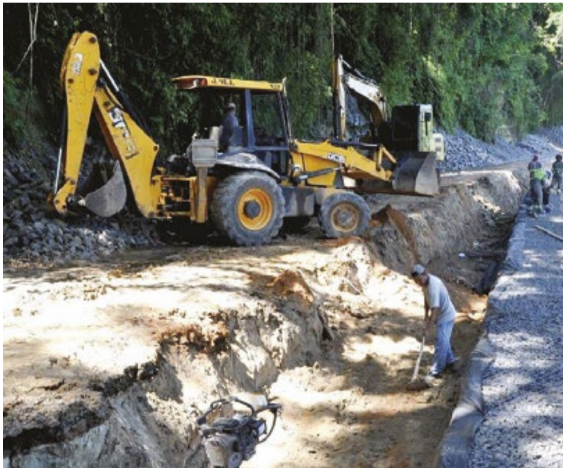
Estrada Parque passa por revitalização completa, com instalação de cerca de 1 km de piso intertravado
