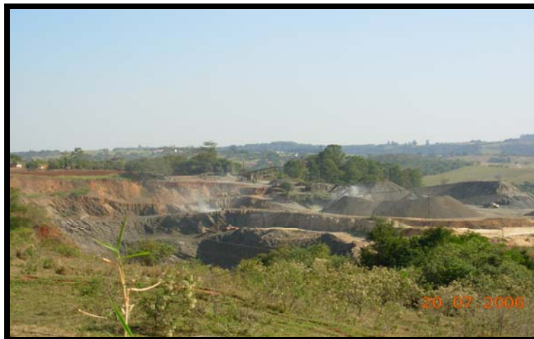
Foto 4.13 - Pedreira instalada em dique de diabásio para produção de brita.
