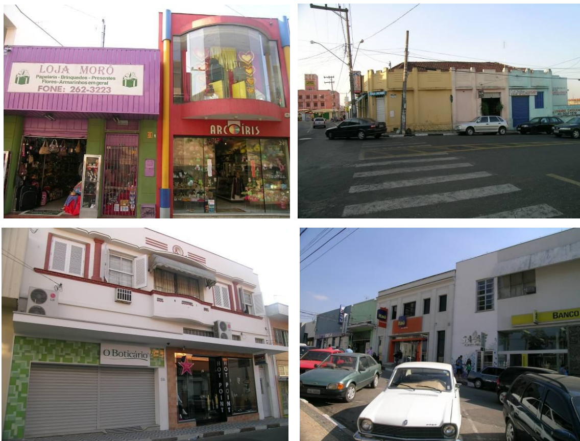
Fig. 50 – Edificações descaracterizadas na região central de Porto Feliz. Fotos: Maria Cristina Wolff de Carvalho. 2008.
