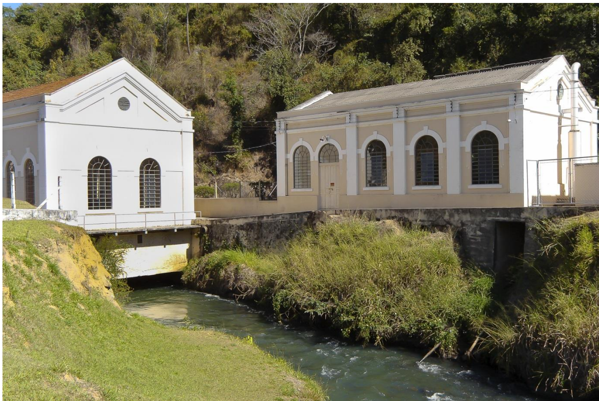
Usina Macaco Branco
