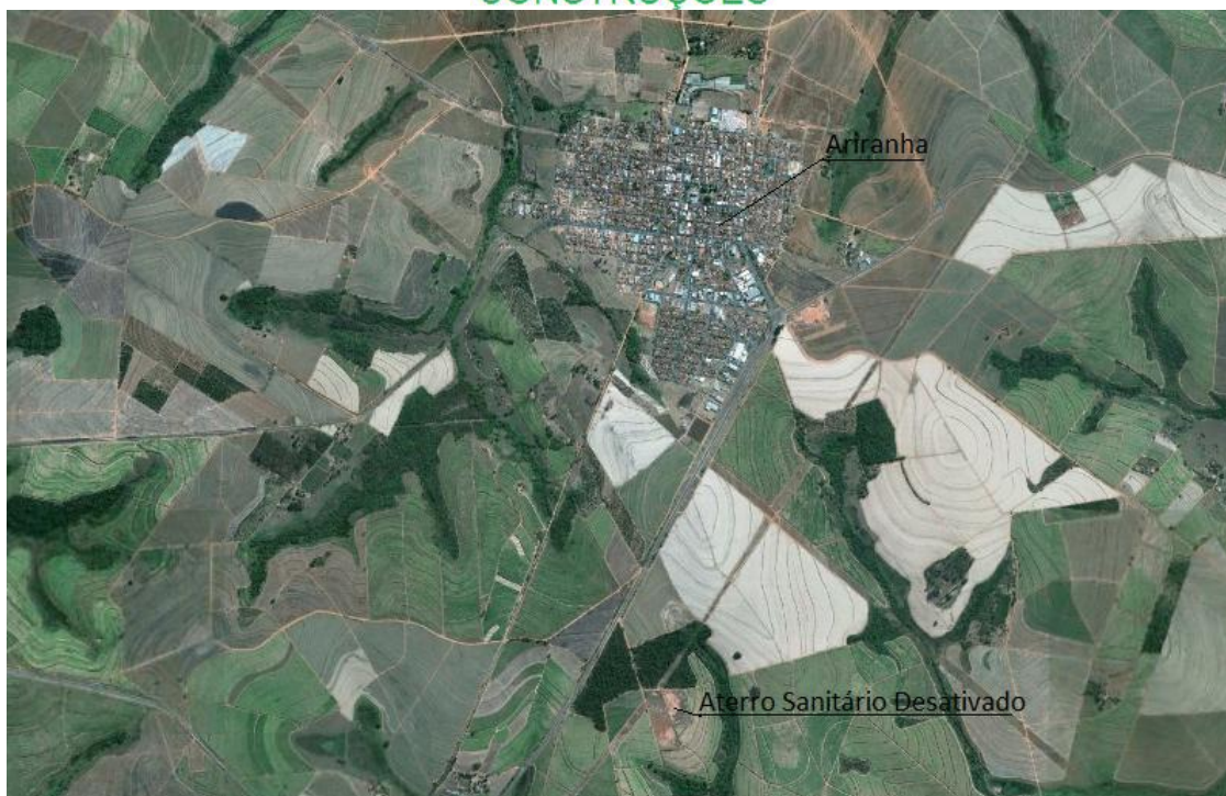
Figura 31 – Localização do Aterro Sanitário Desativado
