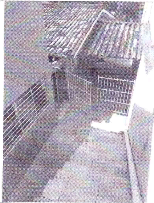
Foto 5 – Vista da parte superior
