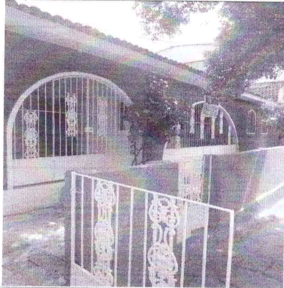
Foto 1 – Fachada Frontal/Porta de acesso
