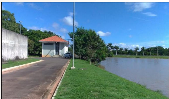
Figura 17 – Vista geral da represa, captação e casa das bombas.
