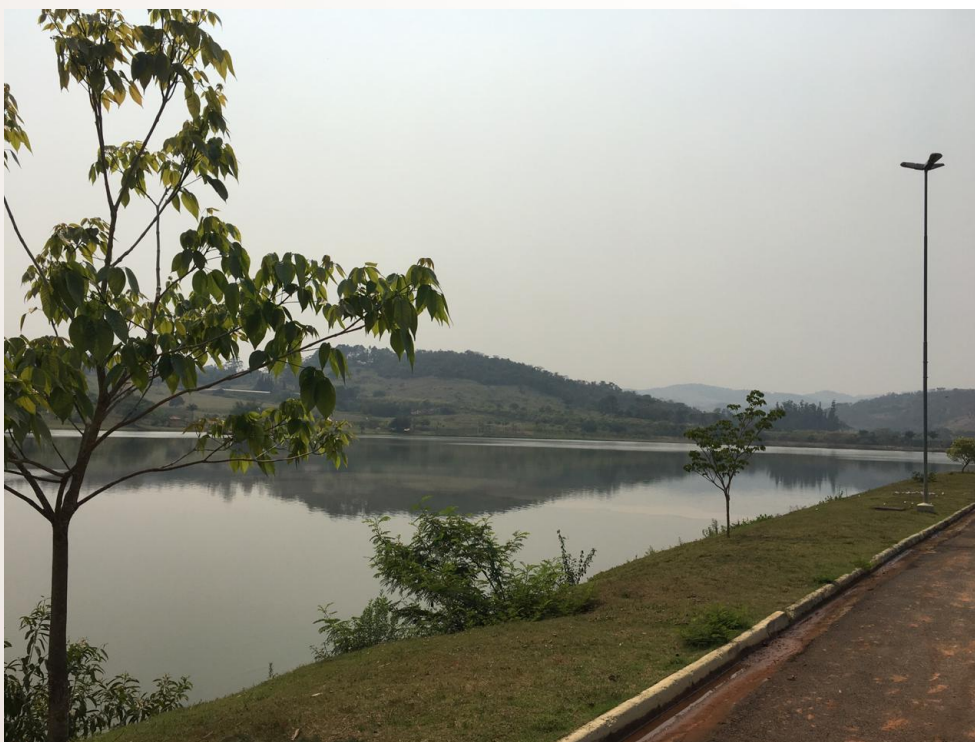
Figura 13 – Represa de captação do Rio Verde
