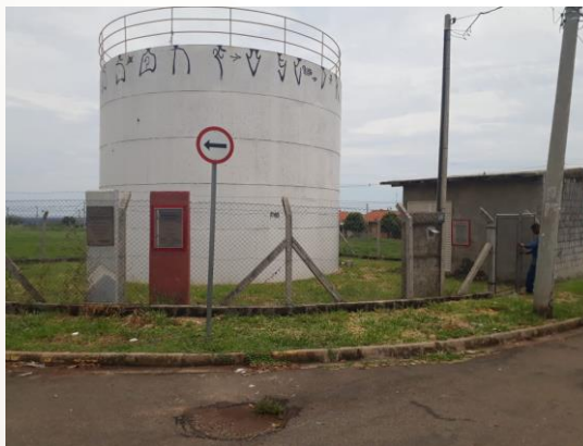
Figura 59 – Localidade do booster nas dependências do reservatório da COHAB 6 devidamente cercado.
