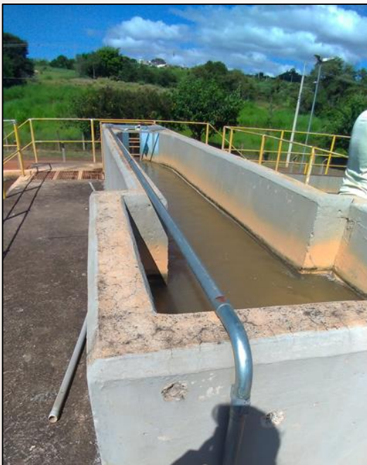
Figura 26 – Vista da entrada de água bruta na ETA
