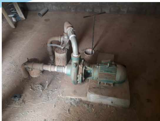
Figura 60 - Booster que abastece a região da COHAB 6.
