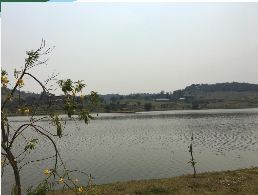
Figura 14 – Represa de Captação do Rio Verde
