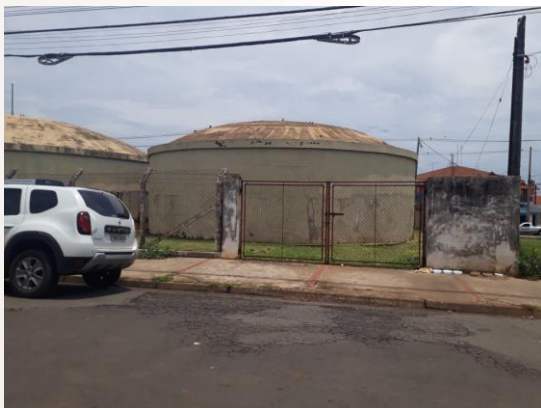
Figura 56 – Localidade do booster nas dependências dos reservatórios do Jd. Paulista devidamente cercado.
