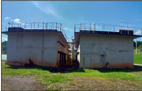
Figura 24 – Vista dos dois módulos de tratamento da ETA.
