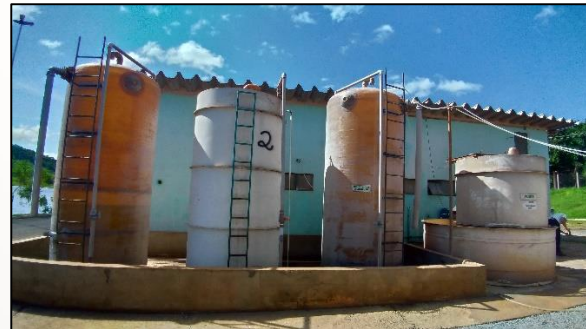
Figura 31 – Três tanques de armazenamento de sulfato de alumínio e tanque de armazenamento de ácido fluossilícico da esquerda para a direita, respectivamente.
