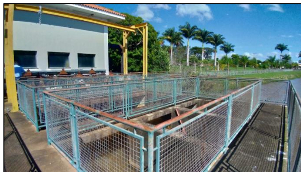
Figura 18 – Vista das estruturas do sistema de captação de água
