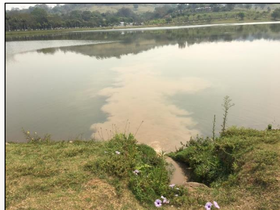
Figura 35 – Descarte da água utilizada para lavagem dos decantadores e filtros na represa de captação
