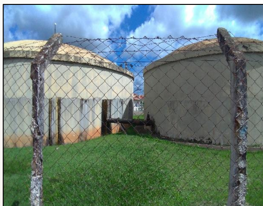
Figura 43 - Reservatório de Distribuição - Jardim Paulista.
