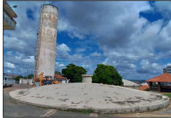
Figura 37 - REN01 (localizado no Centro de Reservação).
