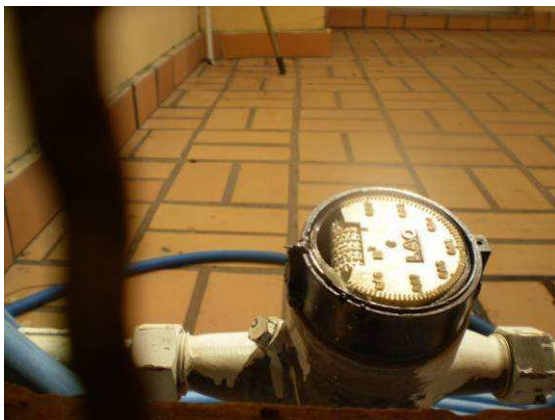
Figura 82. Hidrômetro danificado.
