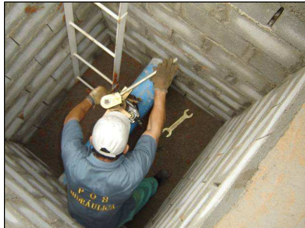
Figura 30. Momento em que a tubulação é furada.
