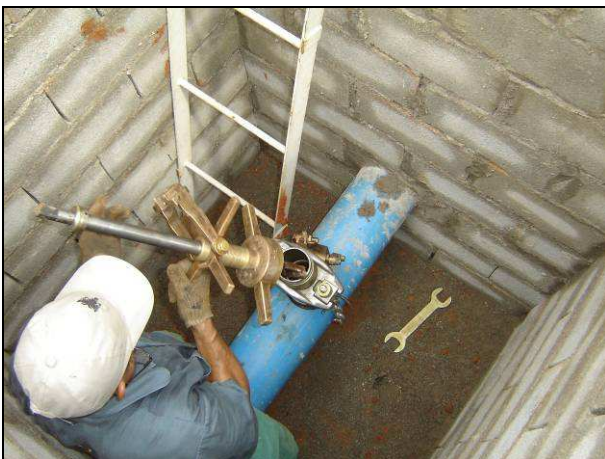
Figura 28. Colocação da máquina no suporte.
