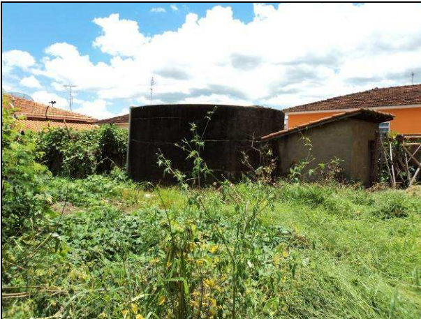
Figura 21: Vista geral do reservatório apoiado desativado.
