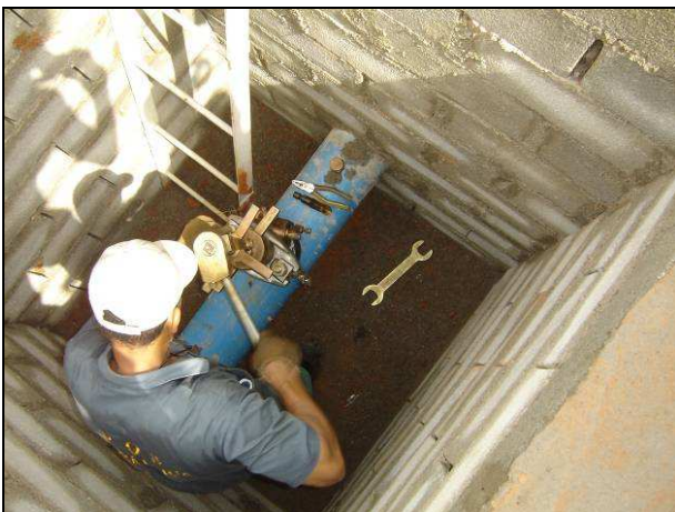
Figura 32. Momento em que a EP está sendo rosqueada na tubulação.
