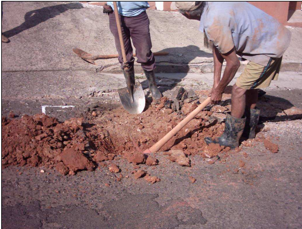
Figura 59. Abertura de vala no local indicado de vazamento.
