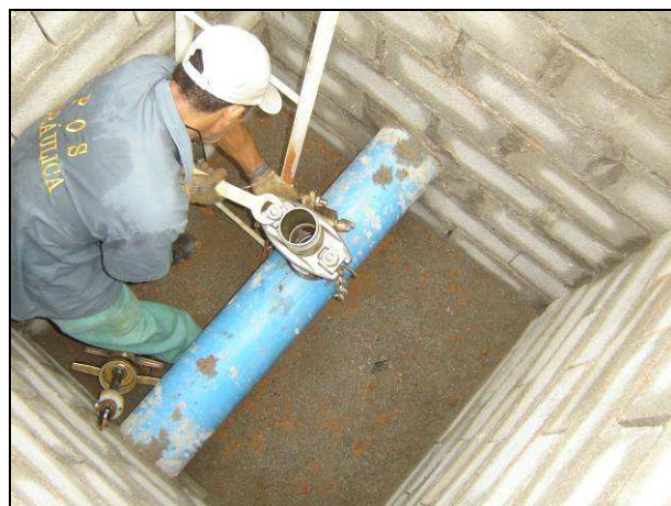
Figura 26. Colocação do suporte da máquina Miller.
