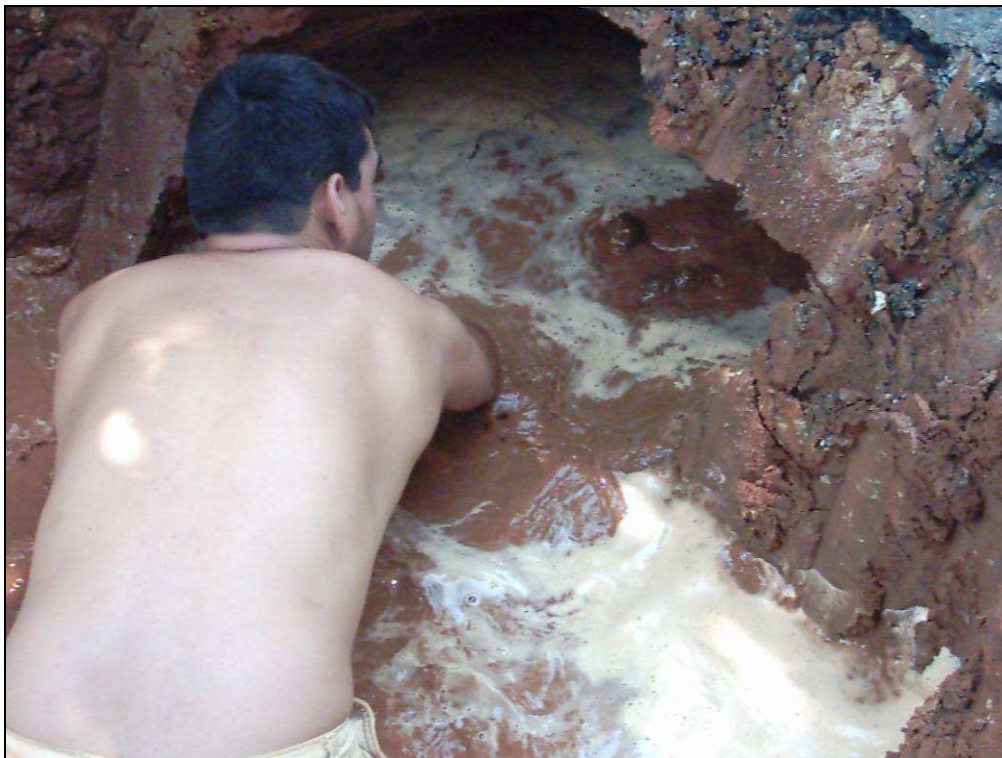
Figura 58. Reparo do vazamento.
