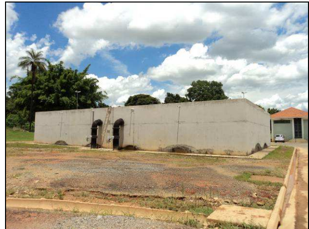
Figura 7: Vista geral das duas câmaras de reservação de água tratada.
