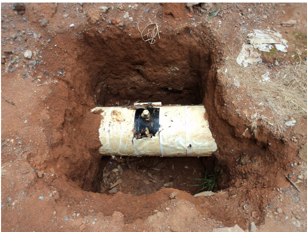
Figura 43. Estação Pitométrica 03 situada na adutora de água tratada na entrada do Reservatório apoiado do Jardim Pacaembu (Central) vinda da ETA.
