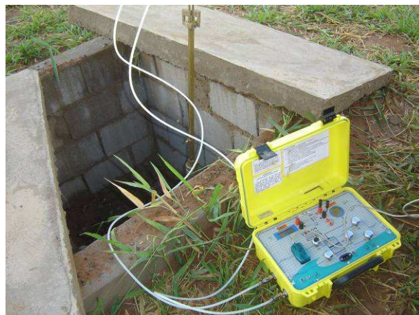
Figura 39. Tubo Pitot inserido em uma tubulação e conectado a um equipamento que contém um sensor de diferencial de pressão.
