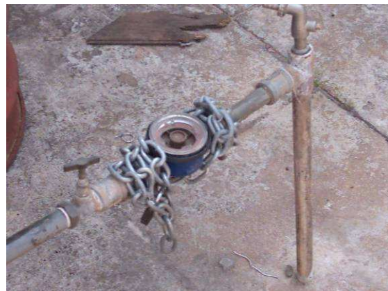
Figura 83. Hidrômetro danificado.
