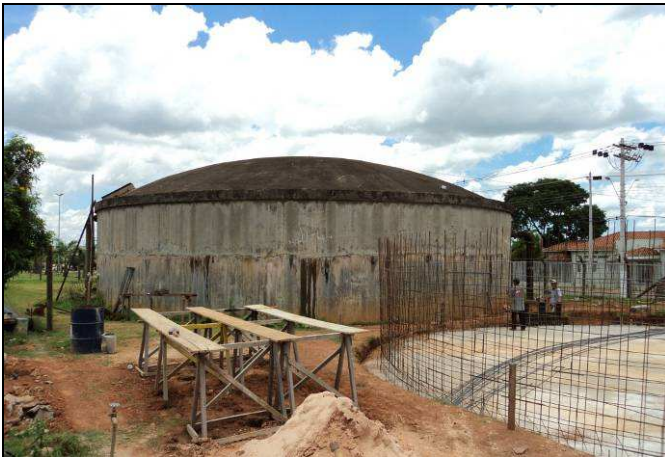
Figura 16: Vista geral do reservatório apoiado de concreto de 1.000m 3 .
