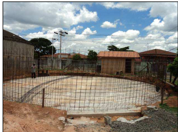
Figura 17: Vista geral da construção do reservatório apoiado de concreto e casa de bomba ao fundo.
