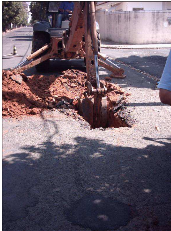
Figura 55. Retroscavadeira abrindo o local do vazamento não visível.
