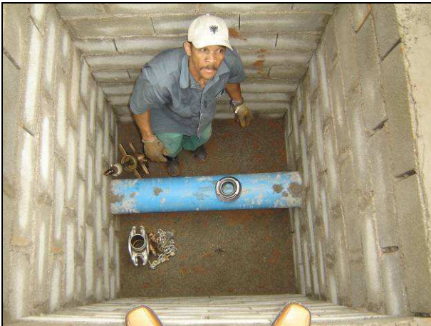
Figura 25. Colocação do anel de borracha.
