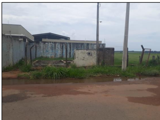
Figura 72 – Vista da entrada da EEE Distrito Industrial que encontrava-se em condições inadequadas
