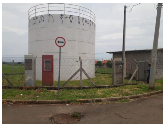
Figura 46 – Localidade do booster nas dependências do reservatório da COHAB 6 devidamente cercado.
