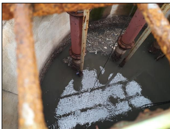
Figura 93 – Poço de sucção da bomba
