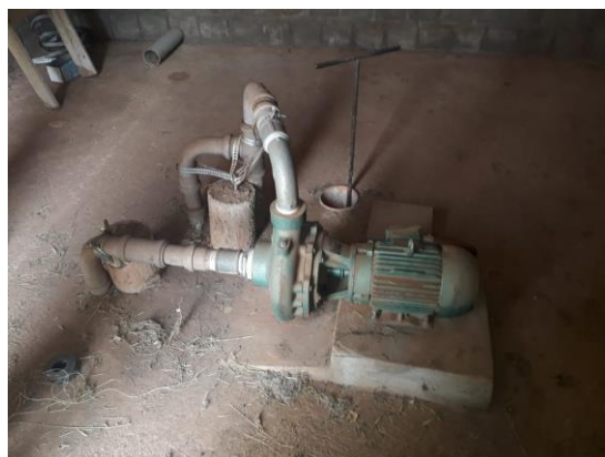
Figura 47 - Booster que abastece a região da COHAB 6.
