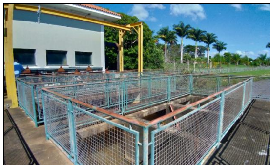
Figura 14 – Vista das estruturas do sistema de captação de água
