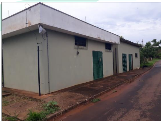
Figura 89 – Casa do gerador e painéis elétricos
