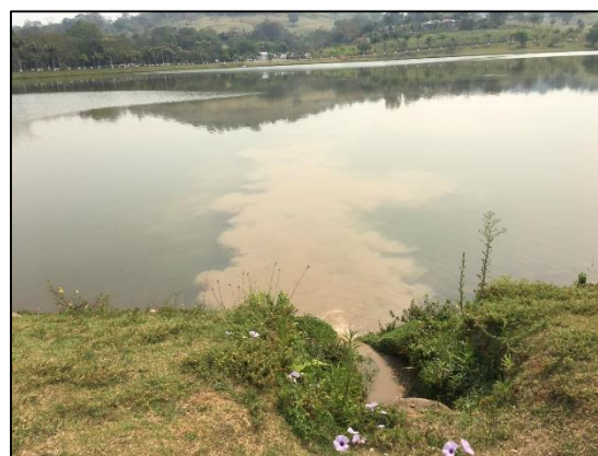
Figura 31 – Descarte da água utilizada pra lavagem dos decantadores na represa de captação
