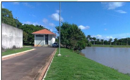
Figura 13 – Vista geral da represa, captação e casa das bombas.
