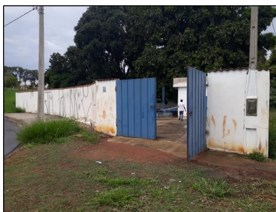
Figura 63 – Vista da entrada da EEE Verona
