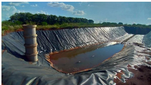
Figura 130 - Vala aberta com lona de impermeabilização.
