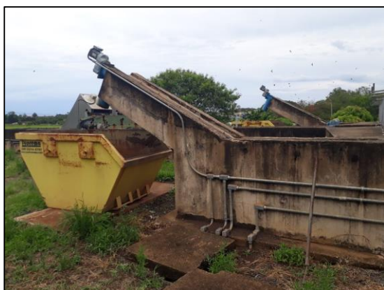
Figura 103 – Descarte de lodo dos adensadores.
