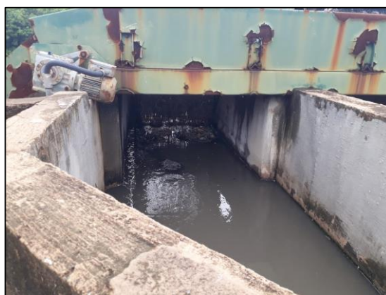
Figura 98 – Passagem de água após o gradeamento.
