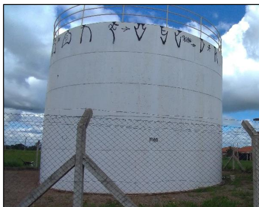
Figura 54 - Reservatório de Distribuição – COHAB 6
