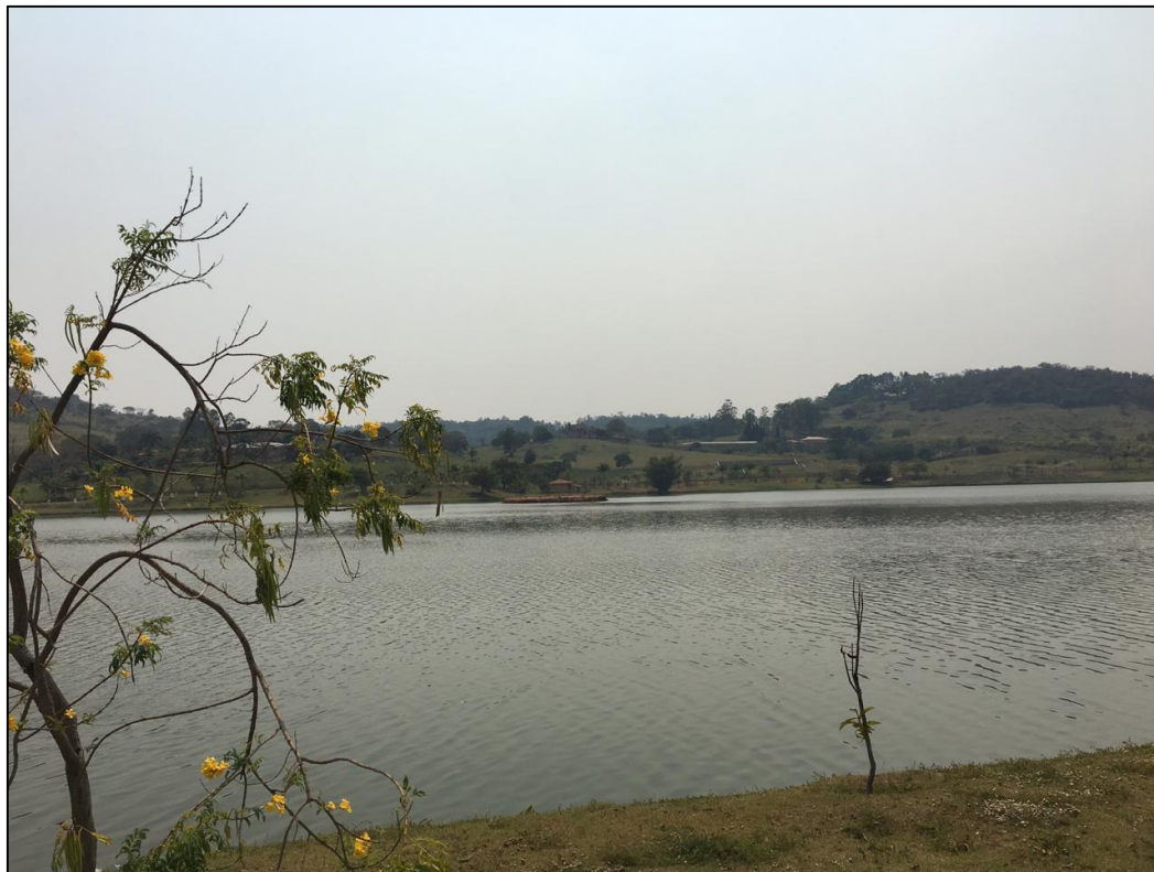
Figura 10 - Represa de Captação do Rio Verde
