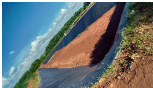
Figura 129 – Vala aberta com lona de impermeabilização.
