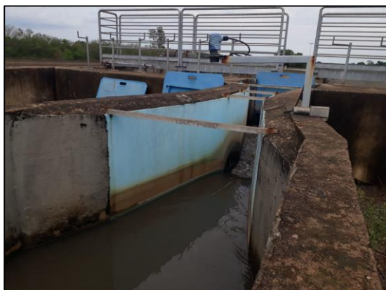
Figura 99 – Calha Parshall
