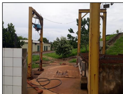
Figura 92 – Gradeamento mecanizado
