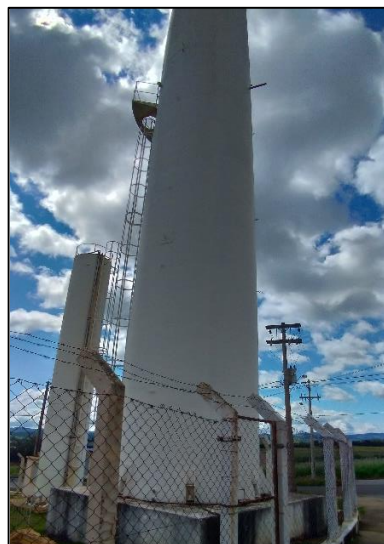
Figura 53 - Reservatório de Distribuição – Jd. América.
