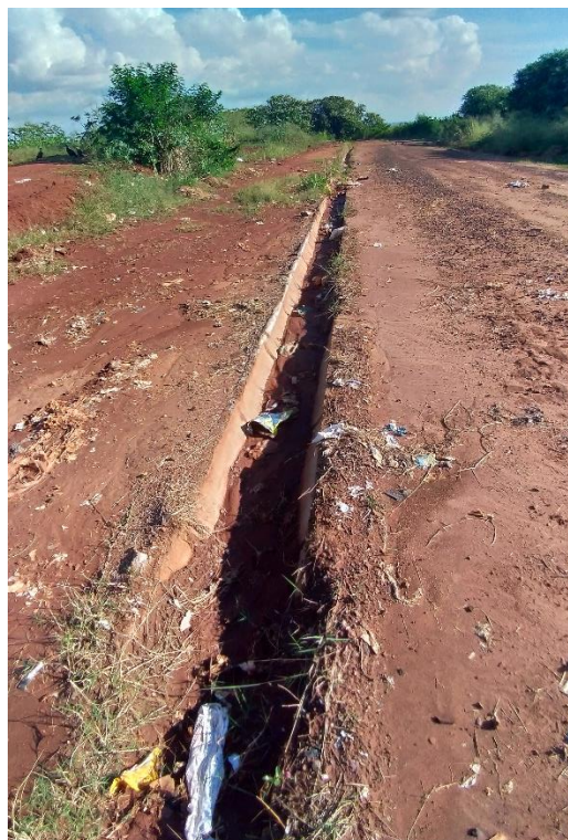
Figura 133 – Canaletas de drenagem pluvial.
