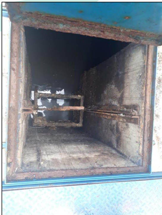
Figura 86 – Gradeamento da EEE Canaã
