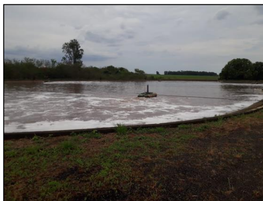
Figura 106 – Lagoa de Aeração 1.
