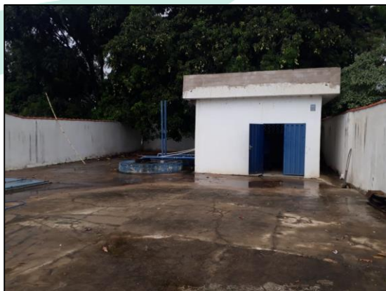
Figura 64 – Vista do interior da EEE Verona
