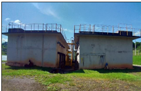
Figura 20 – Vista dos dois módulos de tratamento da ETA.
