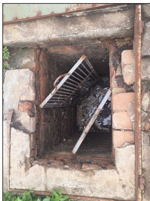
Figura 79 - Gradeamento da EEE Santa Marta
