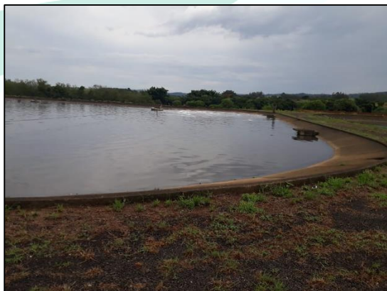
Figura 107 – Lagoa de Aeração 2.
