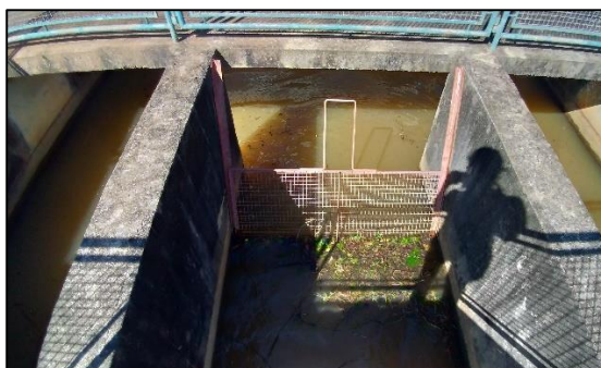
Figura 17 – Sistema de Gradeamento
