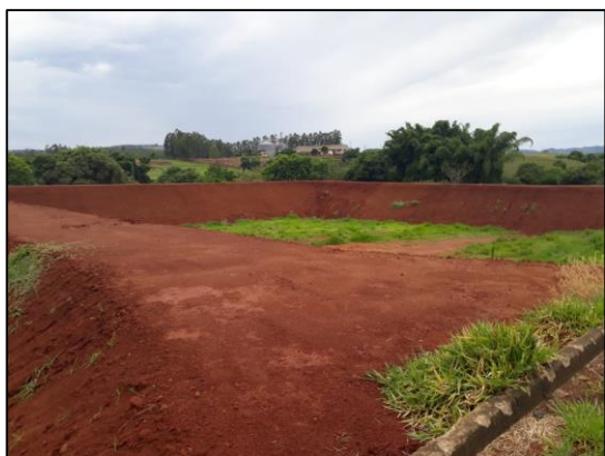
Figura 111 – Leito de secagem de lodo
