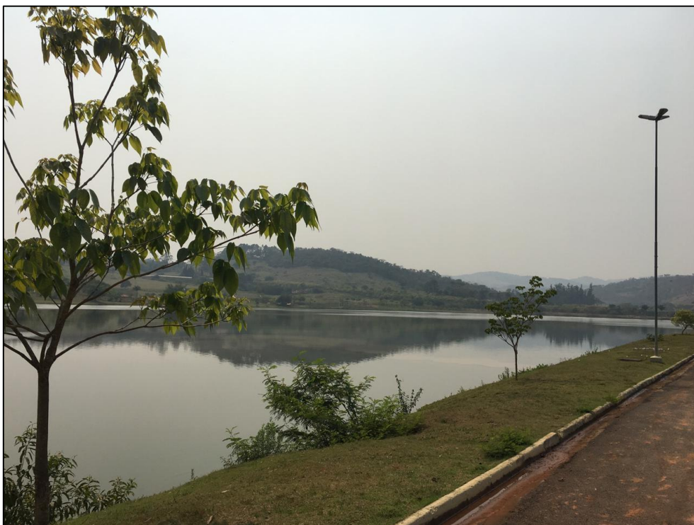
Figura 9 - Represa de captação do Rio Verde
