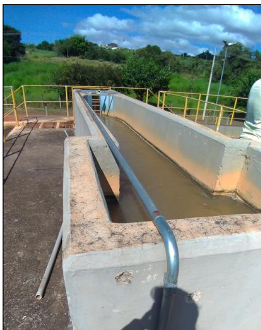
Figura 22 – Vista da entrada de água bruta na ETA
