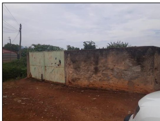
Figura 77 – Vista da entrada da EEE Santa Marta
