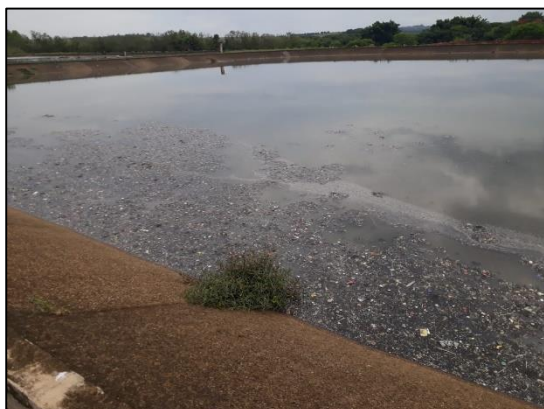
Figura 109 – Lagoa de Sedimentação 1.
