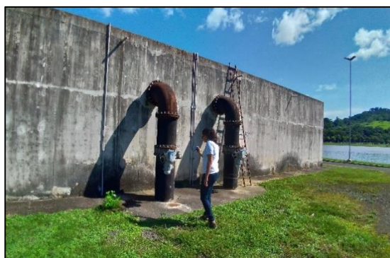
Figura 48 – Reservatório apoiado localizado na ETA.
