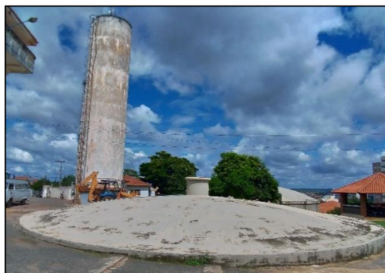
Figura 49 – Reservatório enterrado localizado no Centro de Reservação
