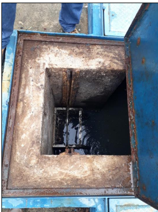
Figura 62- Sistema de gradeamento da EEE Cardoso
