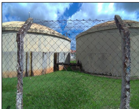
Figura 55 - Reservatório de Distribuição - Jardim Paulista.
