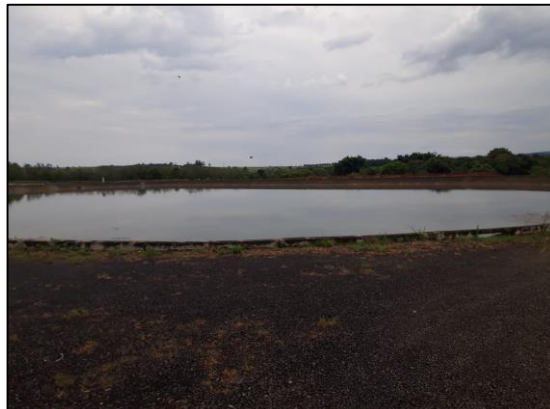
Figura 110 – Lagoa de Sedimentação 2.
