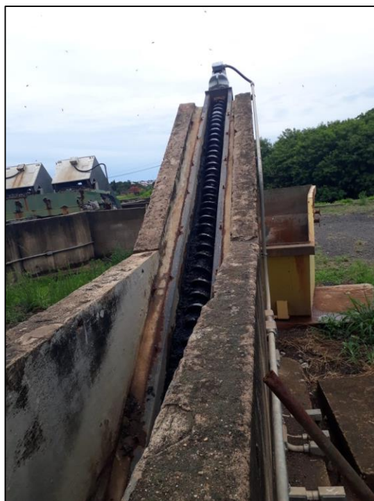
Figura 102 – Eixo de bomba Parafuso..
