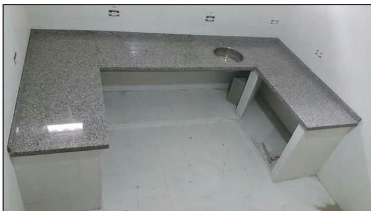
Figura 16 - Referência para granito com frontão e testeira
