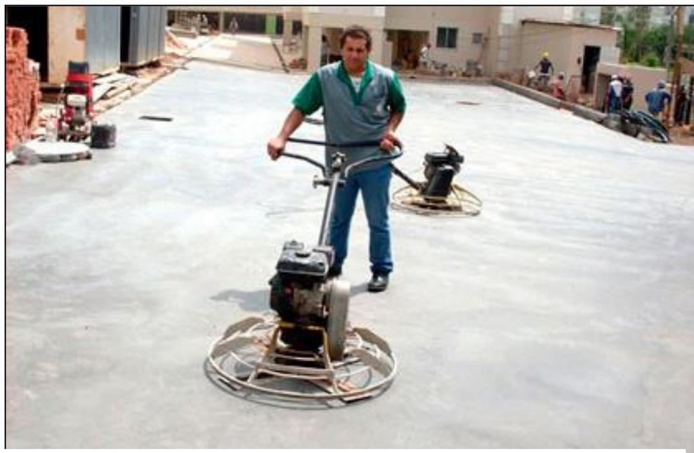
Figura 10 - Referência para acabamento em piso de concreto com alisadora
