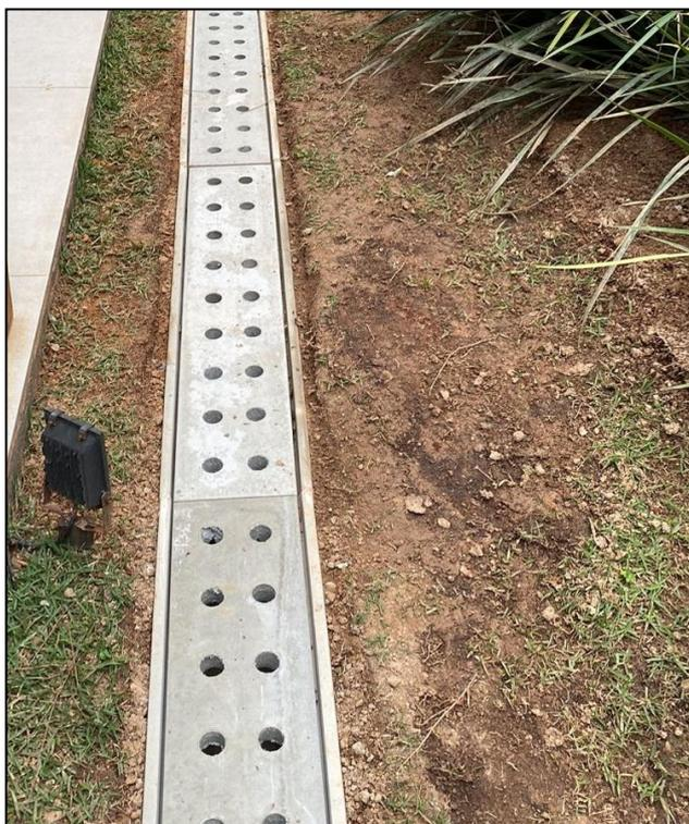
Figura 14 - Referência ilustrativa de canaleta pluvial externa
