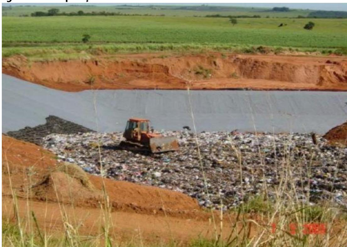
**Figura 15 – Operação de manejo dos RSU.**
