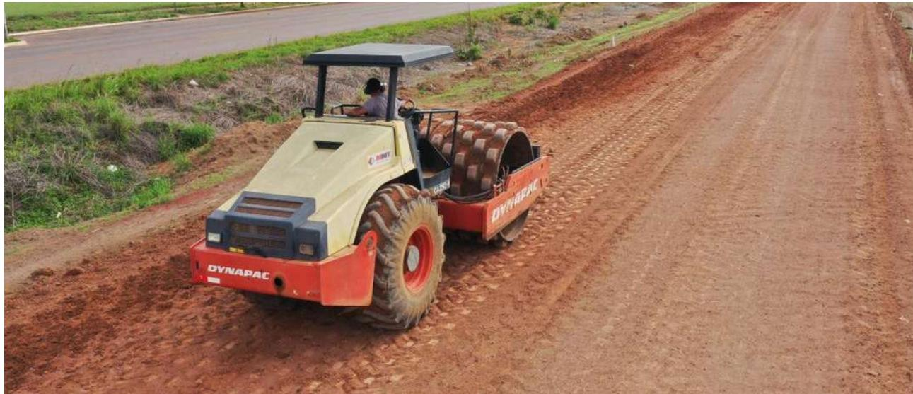
**f) Execução do Pavimento** **Especificação:** Execução de camadas de rachão (30 cm), brita (10 cm), bica corrida (10 cm), imprimação e CBUQ (5 cm).
