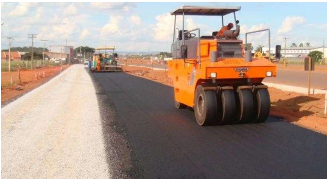
Compactação de pavimento asfáltico com rolo de pneus
