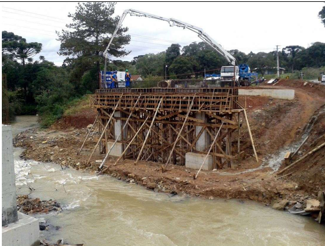
Concretagem de ponte de concreto armado (pilares e blocos)
