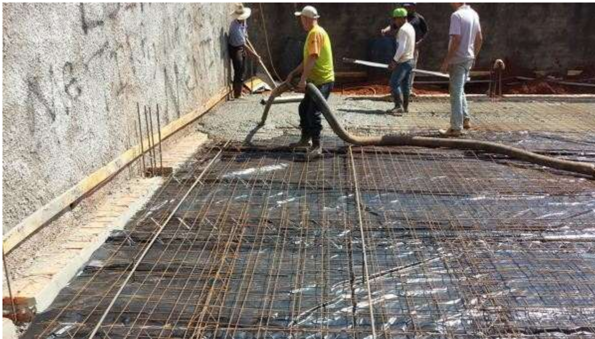
Concretagem de piso de concreto
