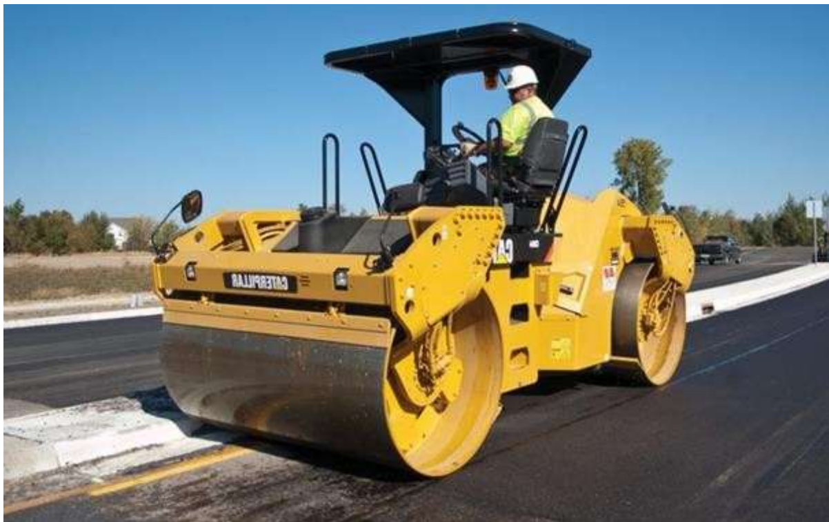
Compactação de pavimento asfáltico com rolo liso
