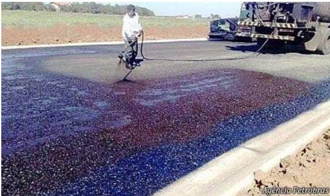
Aplicação de imprimação betuminosa
