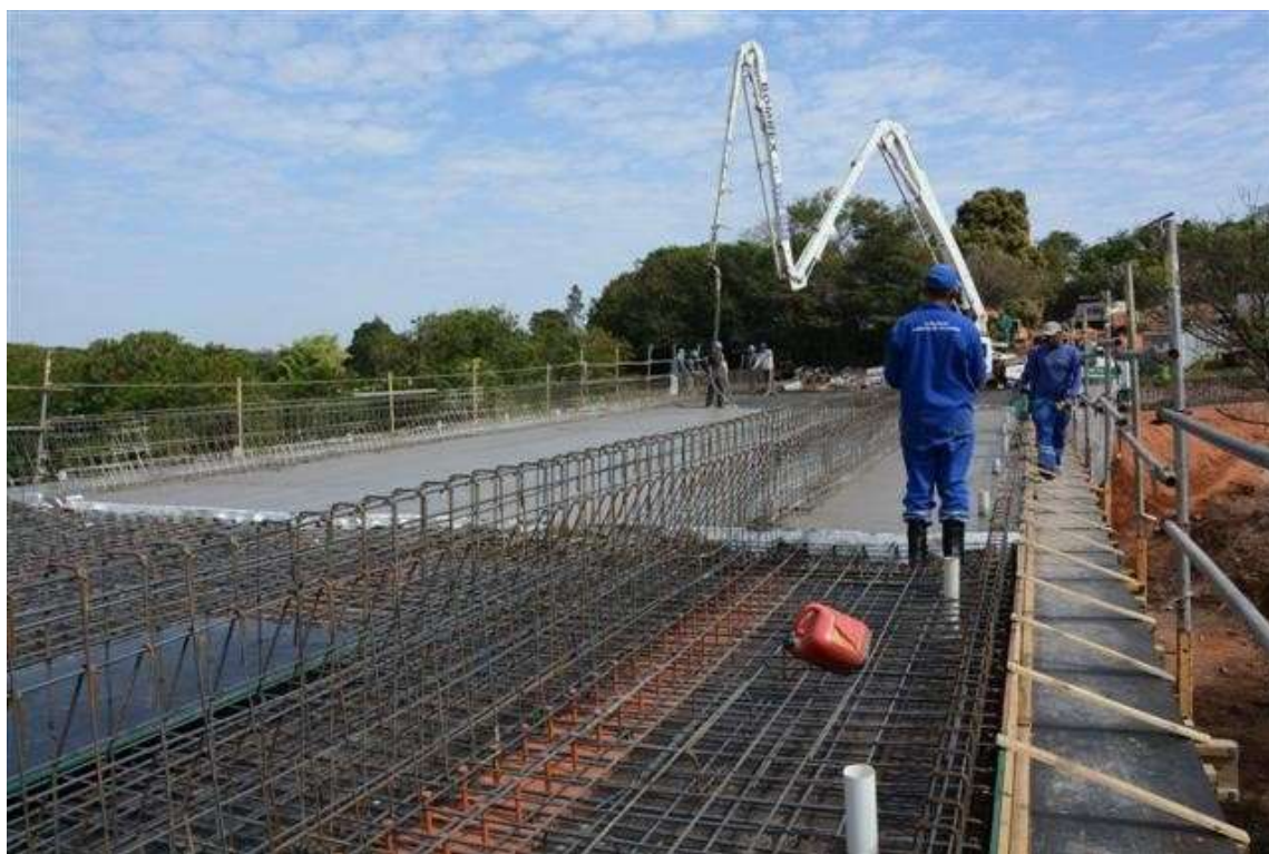
Armadura de uma ponte em concreto armado
