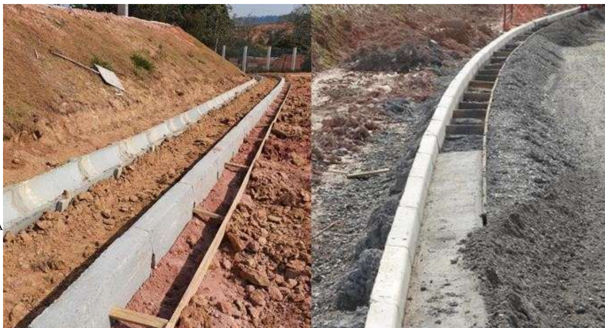
Execução de guias pré-moldadas e sarjetas padrão PMSP
