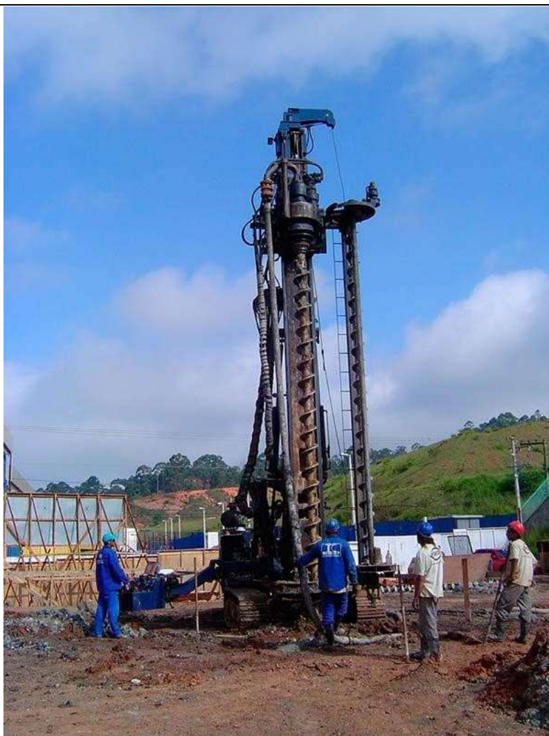
Execução de estaca Hélice Contínua
