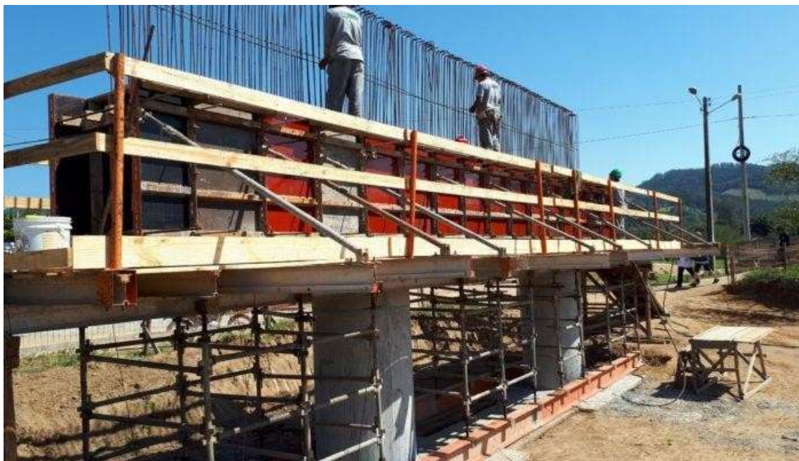
Montagem das formas de uma ponte em concreto armado
