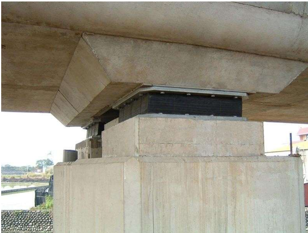
Aparelho de neoprene de ponte em concreto armado
