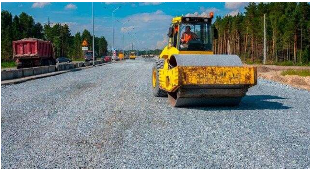
Camada de brita sobre o pavimento
