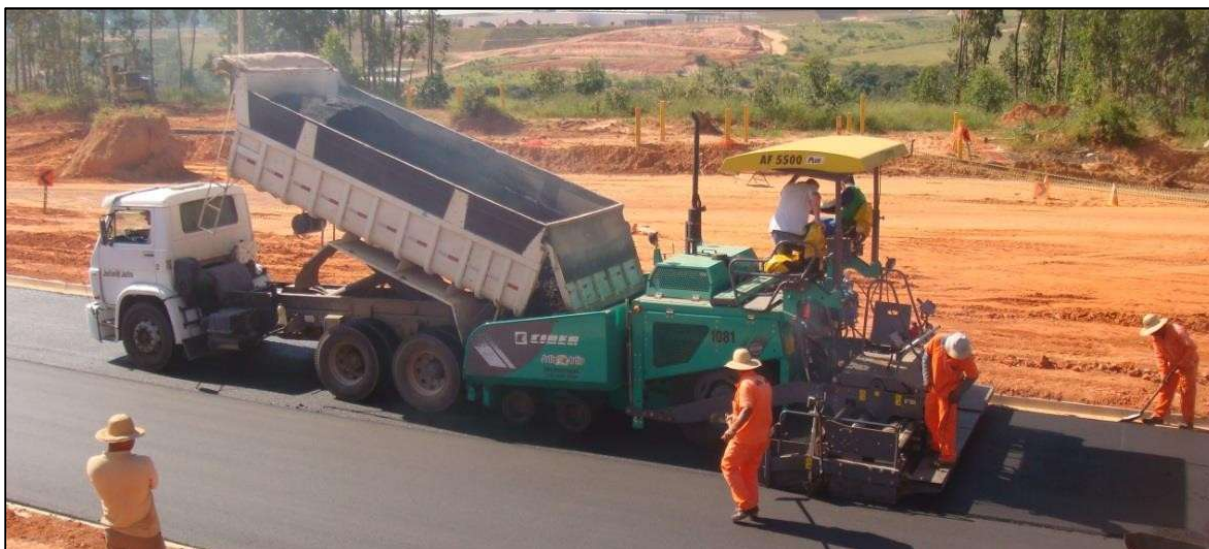
Vibroacabadora executando pavimentação em CBUQ
