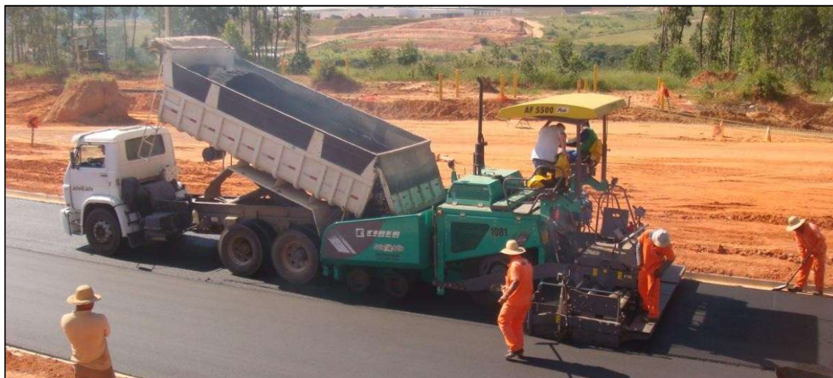
Vibroacabadora executando pavimentação em CBUQ
