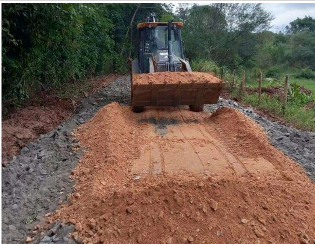
Alteamento de pavimento de acesso à ponte
