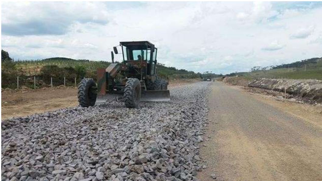
Camada de rachão sobre pavimento
