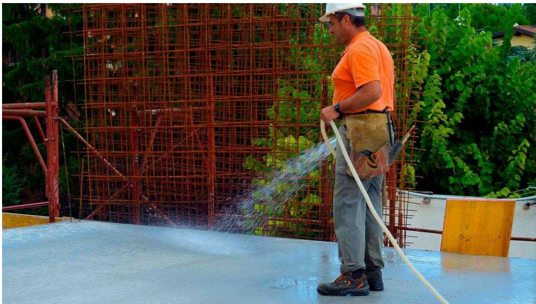
Processo de cura das peças de concreto
