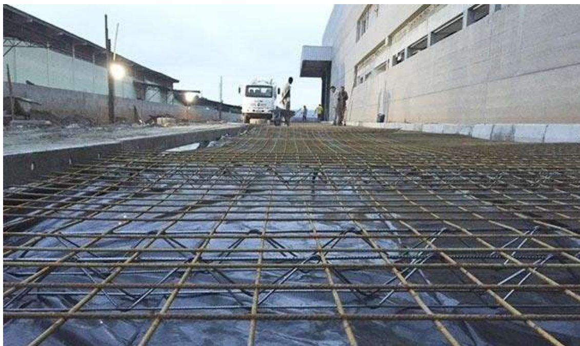
Figura ilustrativa de armadura soldada posicionada com espaçadores sobre lona para receber lançamento da concretagem
