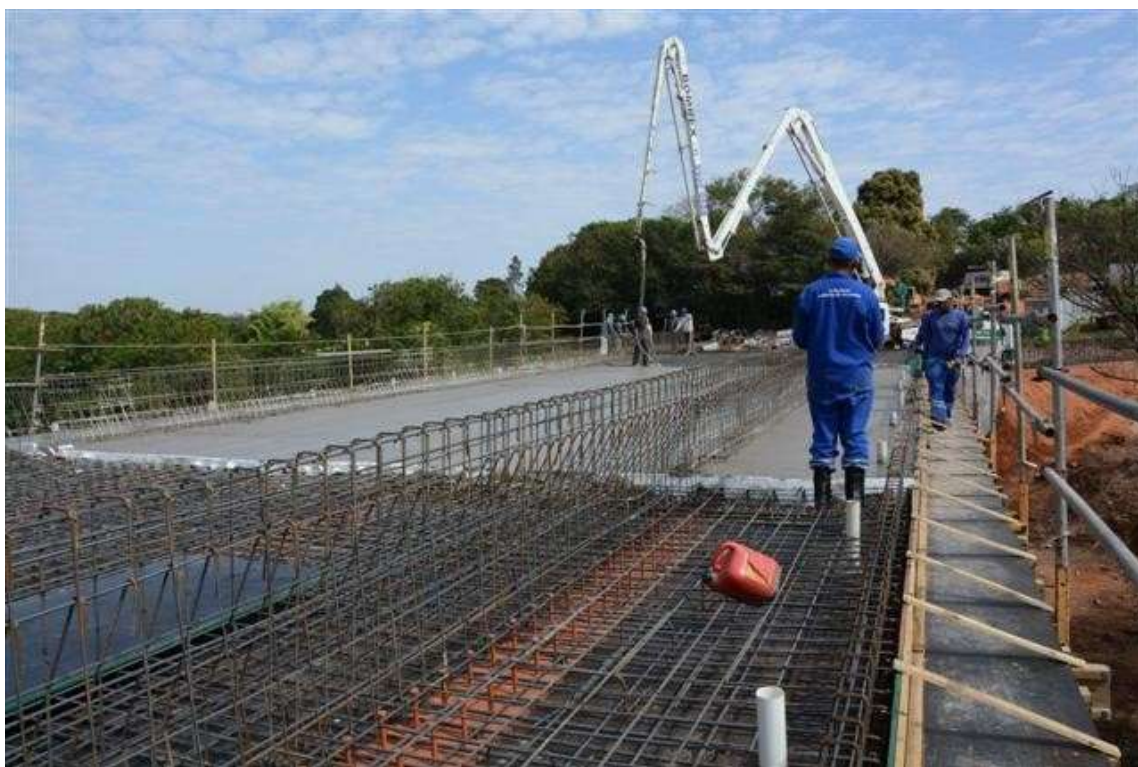
Armadura de uma ponte em concreto armado
