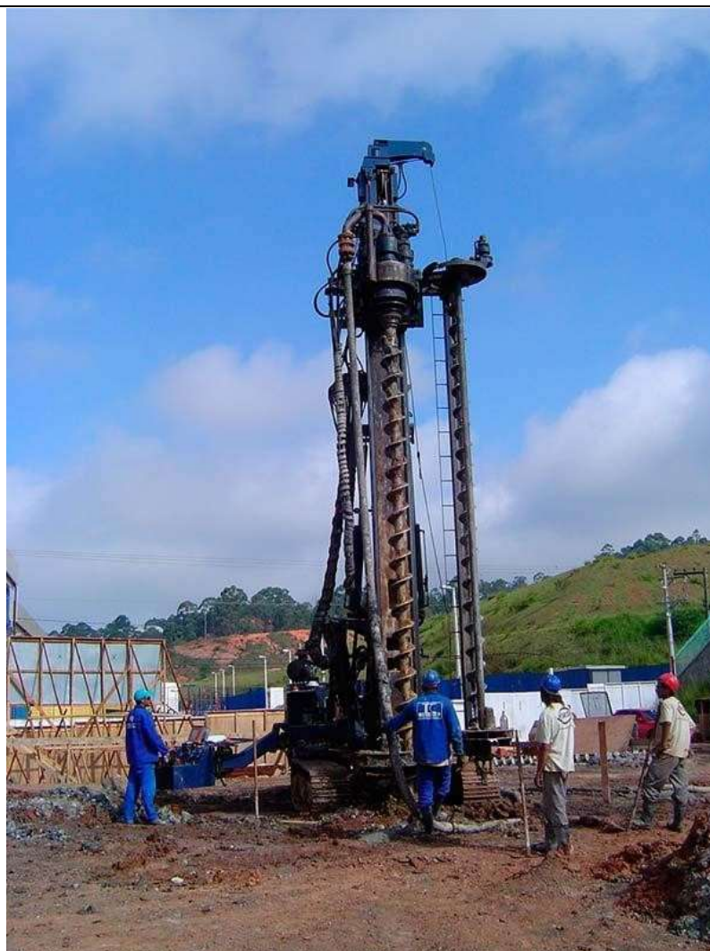
Execução de estaca Hélice Contínua
