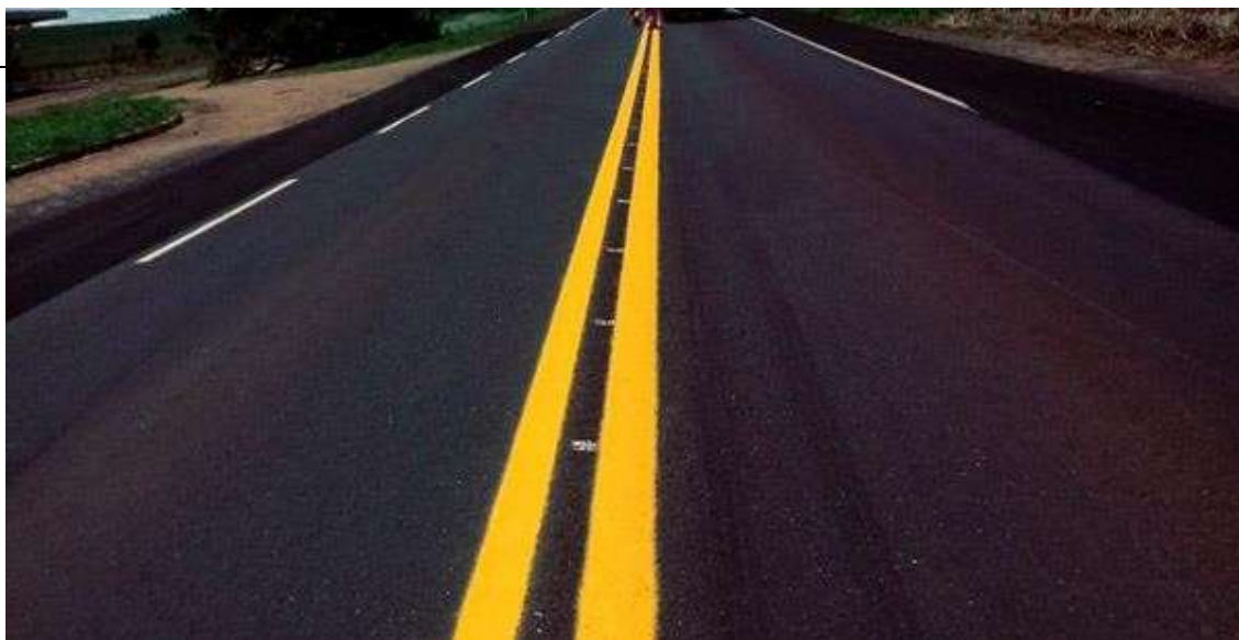
Pintura a base de resina refletorizada em amarelo e branco
