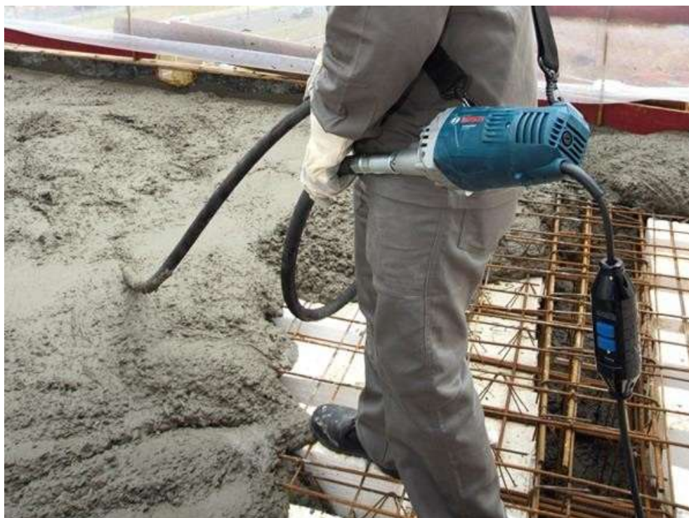
Adensamento de estrutura em concretagem com vibrador
