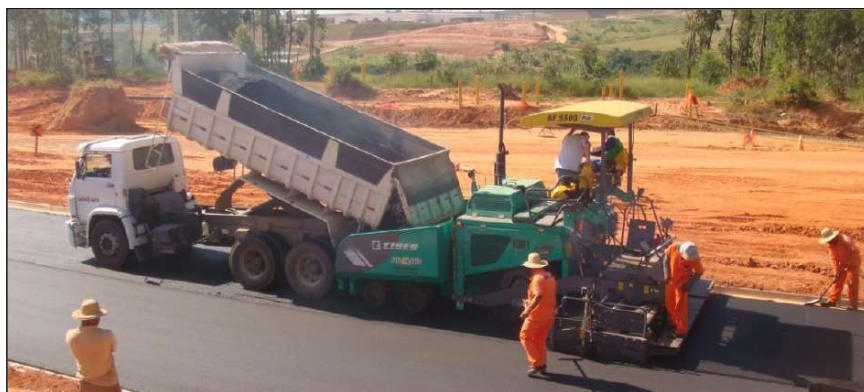
Figura 8 – Vibroacabadora na execução de pavimento asfáltico
