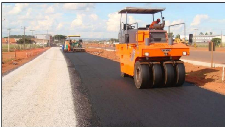
Figura 9 – Compactação de pavimento com rolo compactador de pneus
