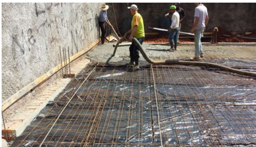
Figura 14 – Concretagem de piso de concreto
