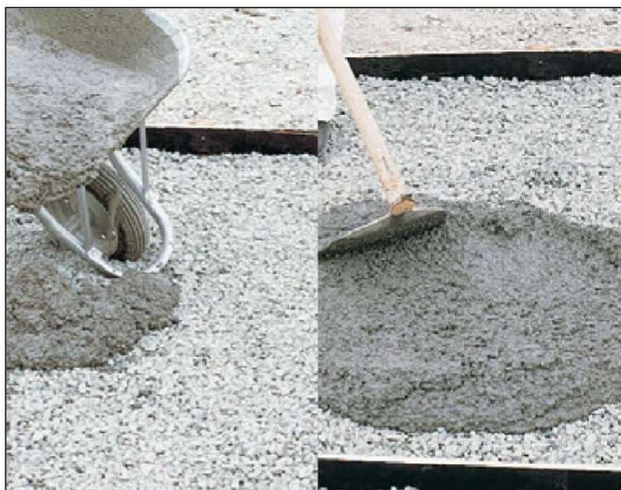
Figura 11 - Aplicação de concreto sobre lastro de brita para calçamento
