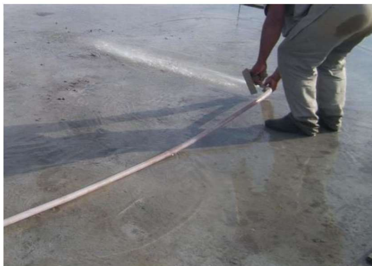
Figura 15 – Processo de cura de pavimento (homem jogando água através de mangueira)
