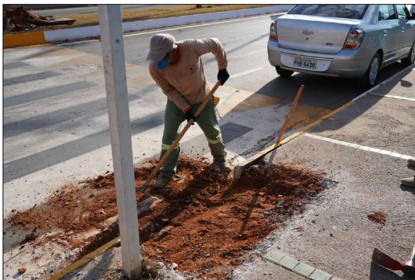
Figura 17 – Demolição de guias, sarjeta, calçamento e escavação para execução de rampa acessível
