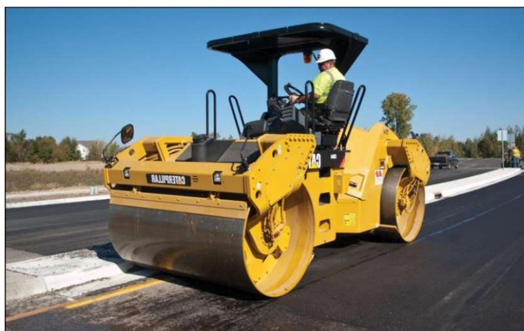
Figura 10 – Compactação do pavimento com rolo compactador vibratório tandem de aço
