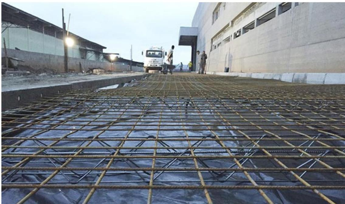
*Figura 6 – Figura ilustrativa de armadura soldada posicionada com espaçadores sobre lona para receber lançamento da concretagem*
