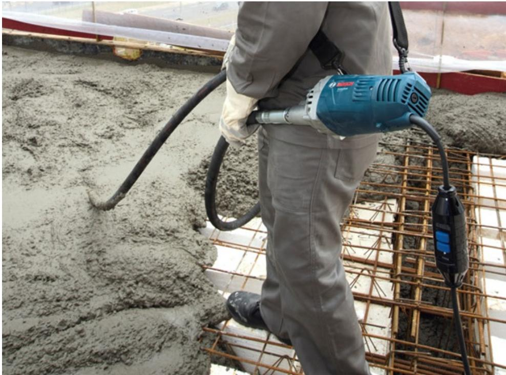
*Figura 7 – Adensamento de estrutura em concretagem com vibrador*
