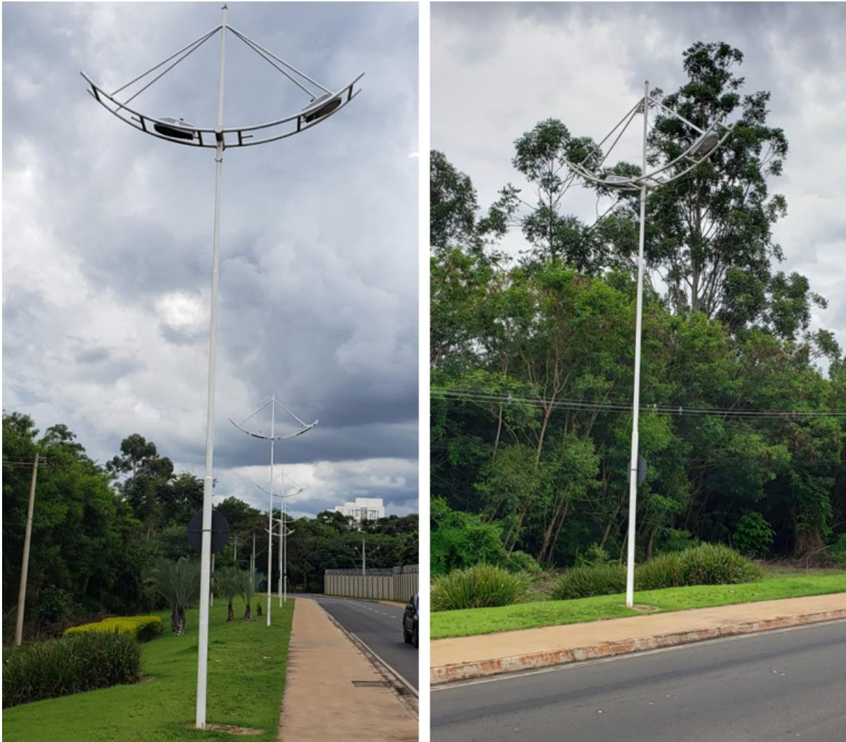
*Figura 12 – Imagem ilustrativa de poste de iluminação com braços do tipo veleiro*
