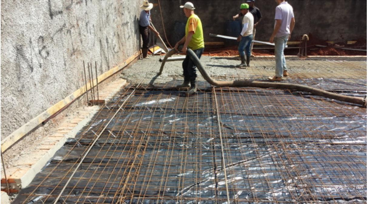
*Figura 8 – Concretagem de piso de concreto*
