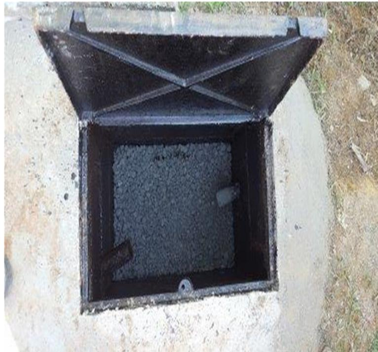
Figura 14 – Exemplo de caixa executada no padrão R1 TELEBRÁS
