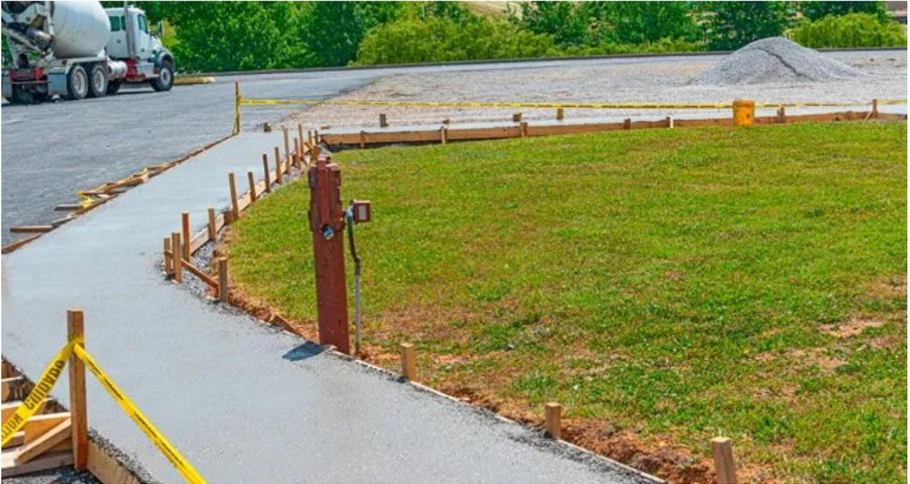
*Figura 5 – Exemplo de estrutura de contenção em formas para concretagem de calçamento*
