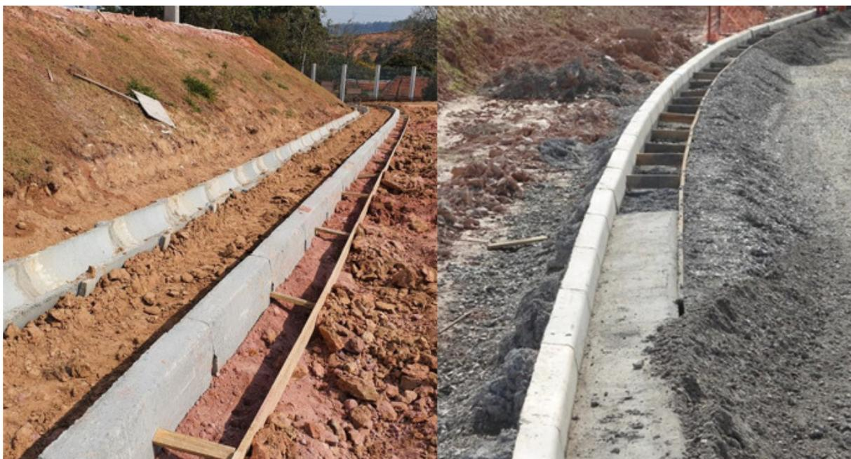
*Figura 10 – Execução de guias pré-moldadas e sarjetas padrão PMSP*
