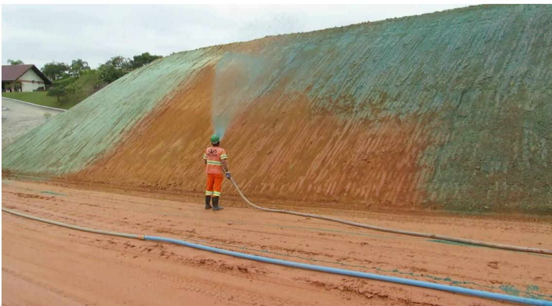
*Figura 17 – Imagem ilustrativa de execução de serviço de plantio com hidrossemeadura*
