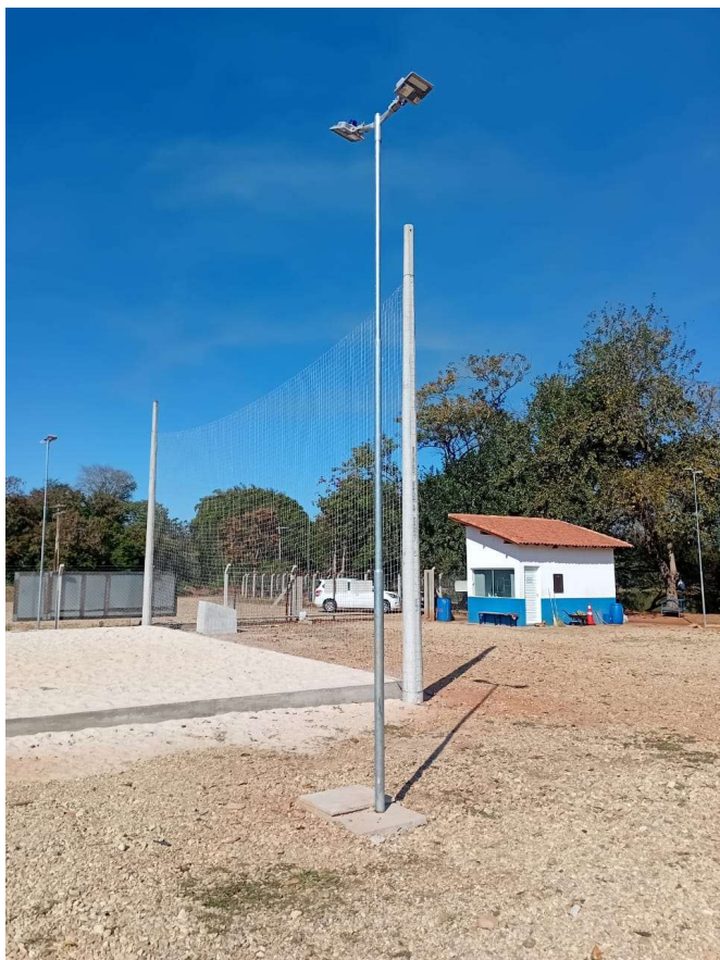
Poste metálico a remover.
