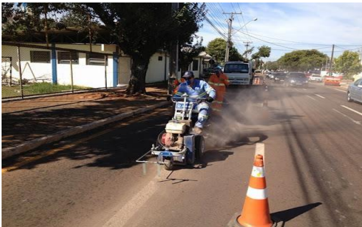
REMOÇÃO DA PINTURA EXISTENTE
