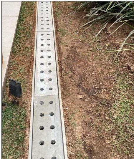
Figura 14 - Referência ilustrativa de canaleta pluvial externa
