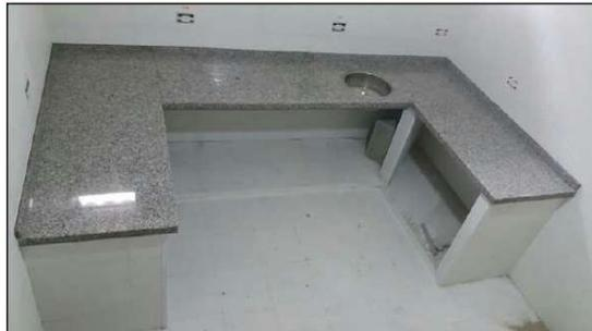
Figura 16 - Referência para granito com frontão e testeira
