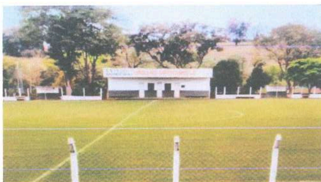
Estádio Municipal "Ver. Urbano Archangelo"
