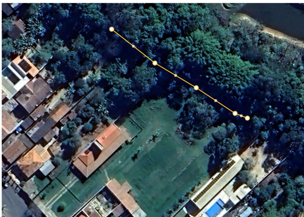
Trecho da Obra do Emissário de esgoto tronco – Rua Visconde de Indaiatuba
