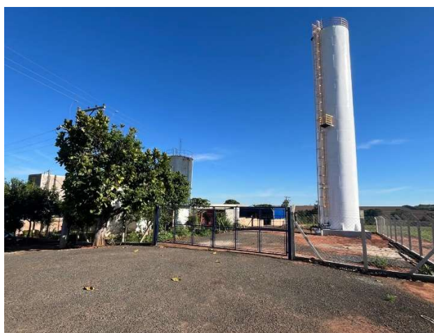
Obras de Instalação da Caixa de Água e Fechamento com alambrado da ETA Hugo Ernesto Muller em Tujuguaba.
