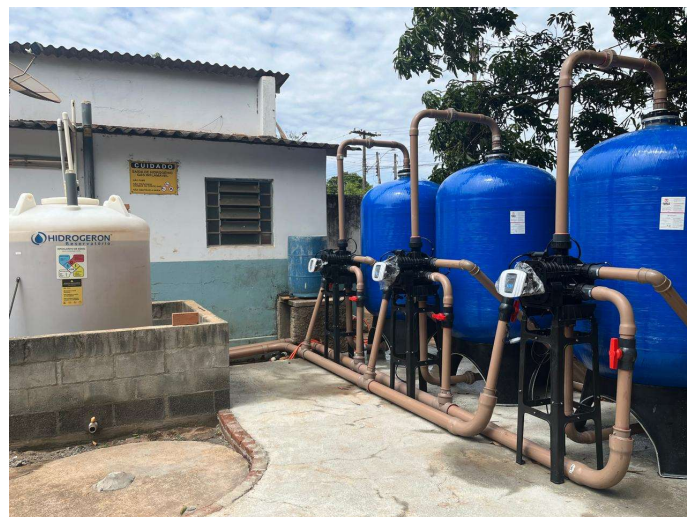
Instalação de 03 filtros para ETA Enos Bonini no Bairro Santa Rita.
