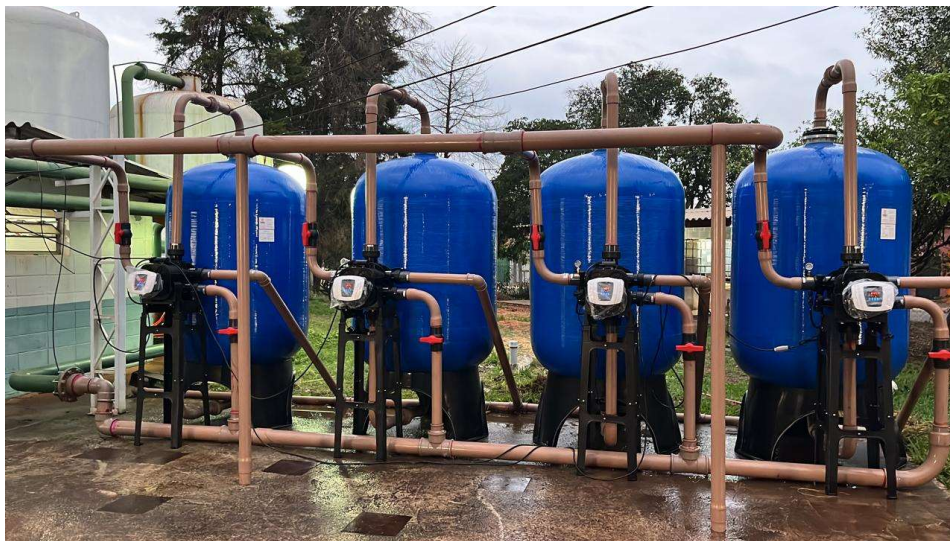
Instalação de 4 filtros para ETA Francisco Fernandes – Jardim Bela Vista
