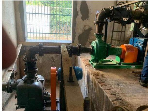
Instalação do Conjunto de Motobombas na Estação Elevatória de Esgoto.
