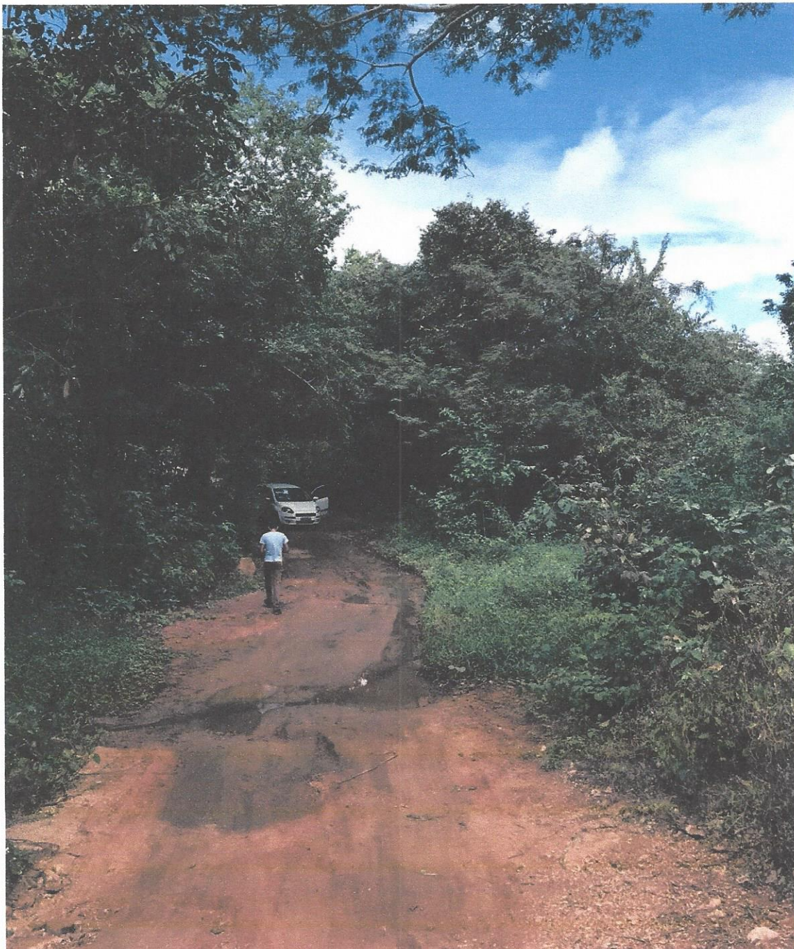
Foto 04: Local onde será construída a Passagem Molhada.
