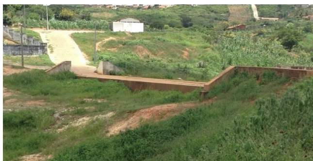
Foto 3 – Vista do vertedouro
