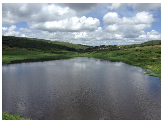
Foto 1 – A partir da parede, vista do açude
