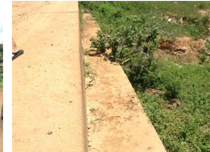
FOTO 2 - VISTA A JUSANTE DO VERTEDOURO ATUAL
