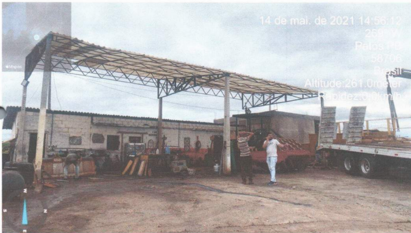
OFICINA/MANUTENÇÃO DE EQUIPAMENTOS E MAQUINAS
