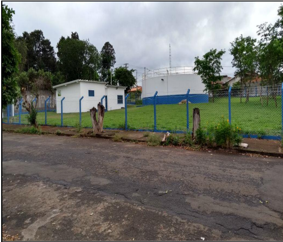
Figura 28 - Reservatório Santa Luiza
