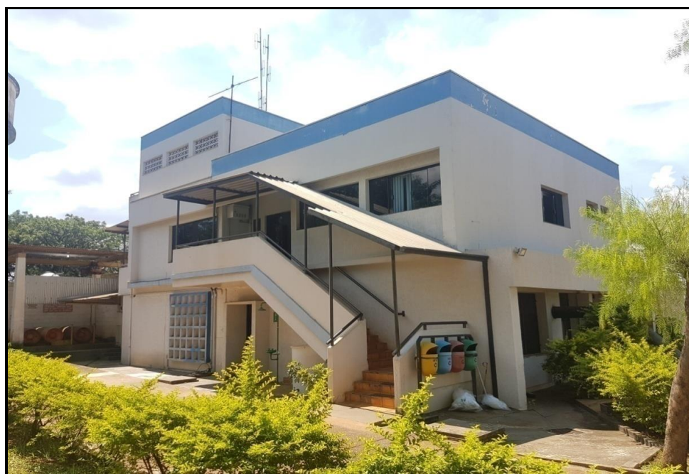
Figura 9 - Estação de tratamento de água
