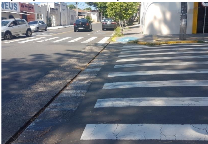
Figura 57 - Sarjetão para travessia de esquinas
