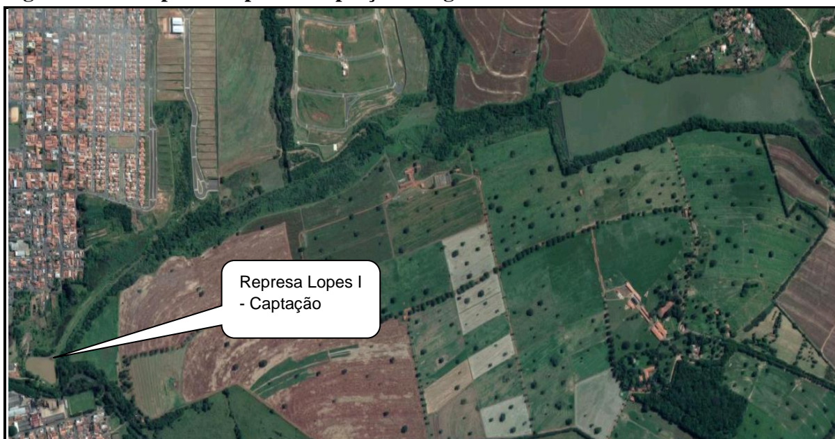
Figura 3 - Represa Lopes I - Captação de água bruta
