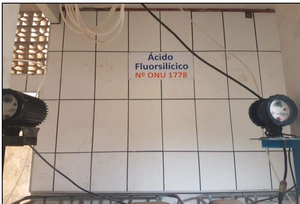
Figura 17 - Dosador de Ácido fluossilícico
