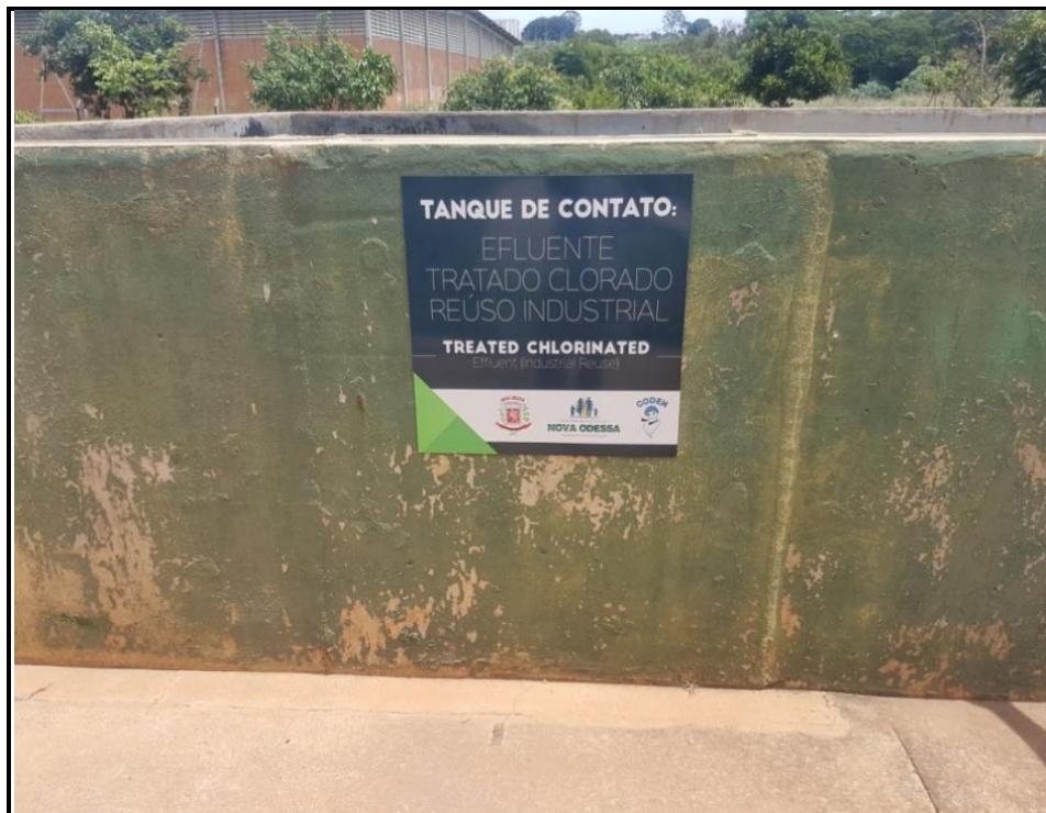
Figura 39 - Tanque de contato para cloração do efluente
