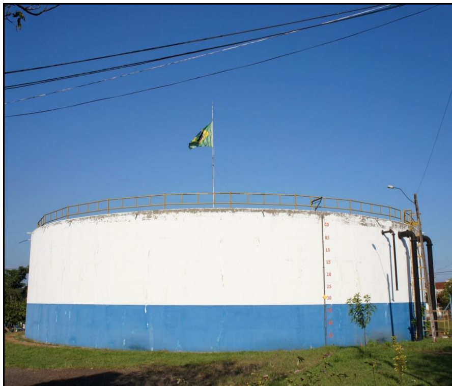
Figura 23 - Reservatório apoiado - 5.000 m 3
