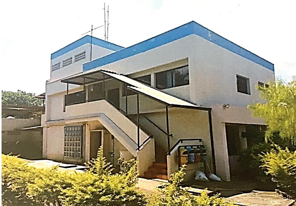
Figura 26 - Estação de tratamento de água
