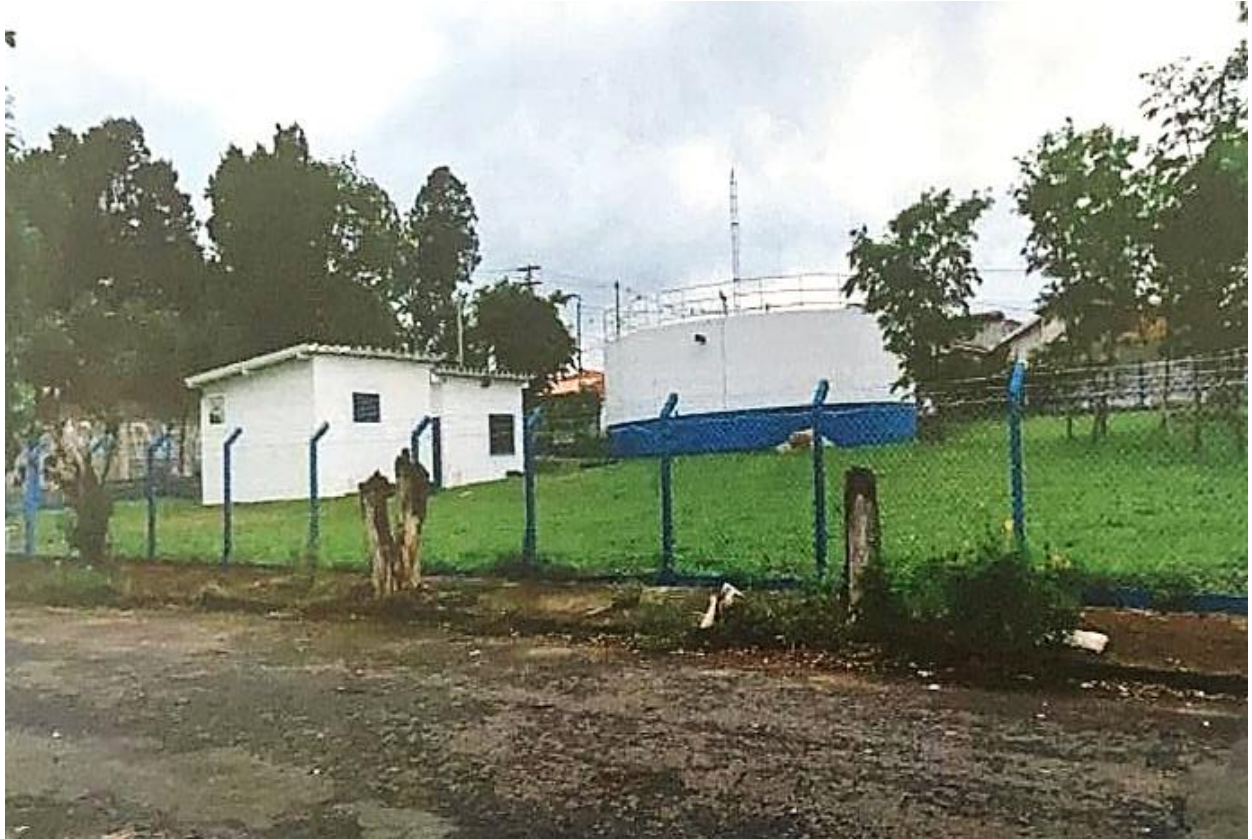
Figura 33 - Reservatório Santa Luiza
