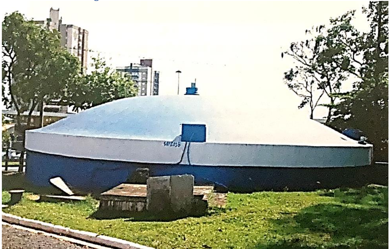
Figura 29 - Reservatório Semienterrado – 1.000m 3
