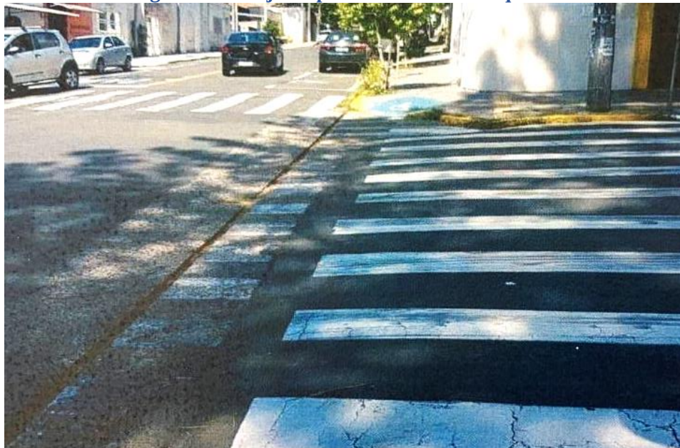
Figura 46 - Sarjetão para travessias de esquinas
