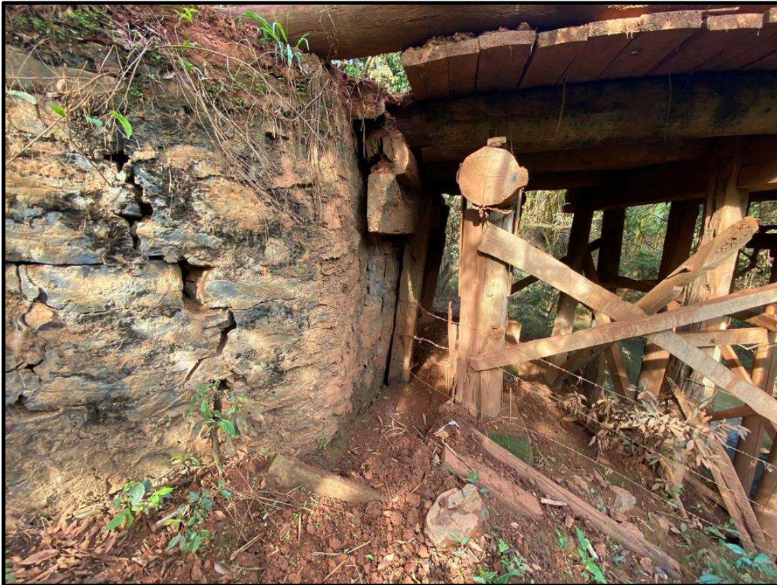
Figura 05 – Ponte sobre o Córrego Rancho Novo.
