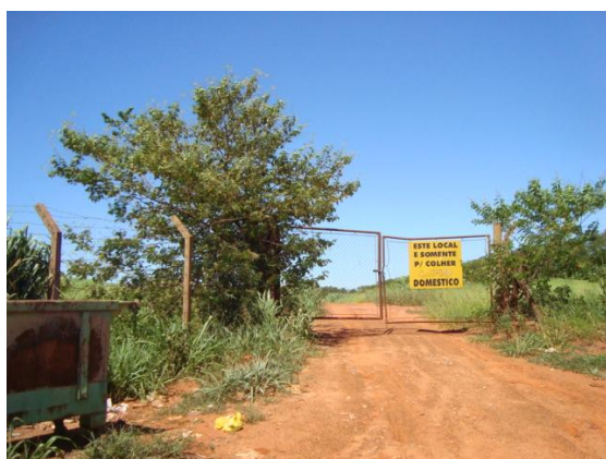
FOTO DO LOCAL DO ATERRO EM VALAS
