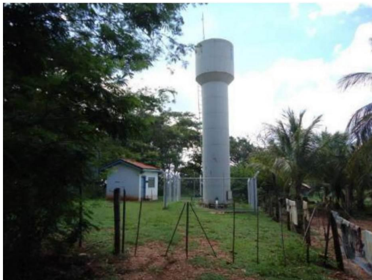
FIGURA 70 – Instalações do sistema Lote 76
