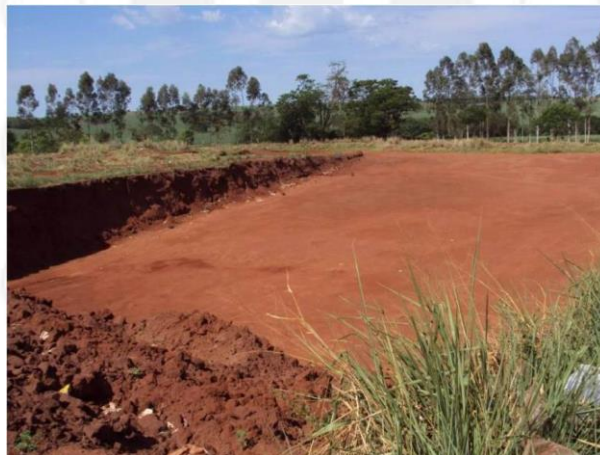
FIGURA 237 - Construção da nova trincheira
