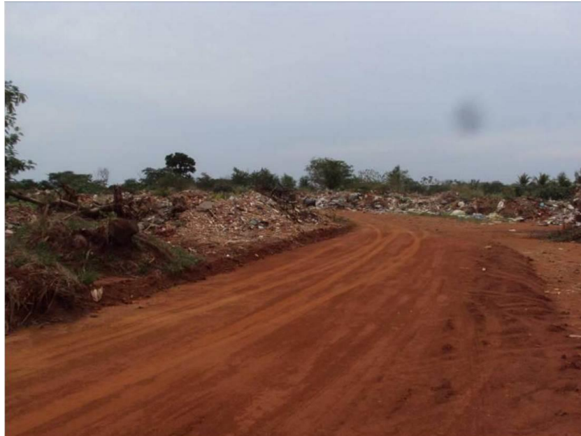
FIGURA 250 – Local de disposição irregular de resíduos
