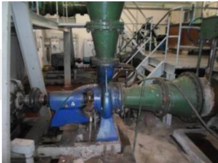
FIGURA 57 – Conjunto motobomba responsável pela elevação da água do reservatório aterrado para o reservatório elevado central
