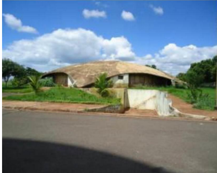
FIGURA 59 – Reservatório semi-aterrado do Jardim Aeroporto
