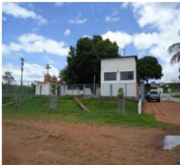
FIGURA 41 – Estação de Sistema de Recalque 3 onde é realizado o processo de tratamento de água
