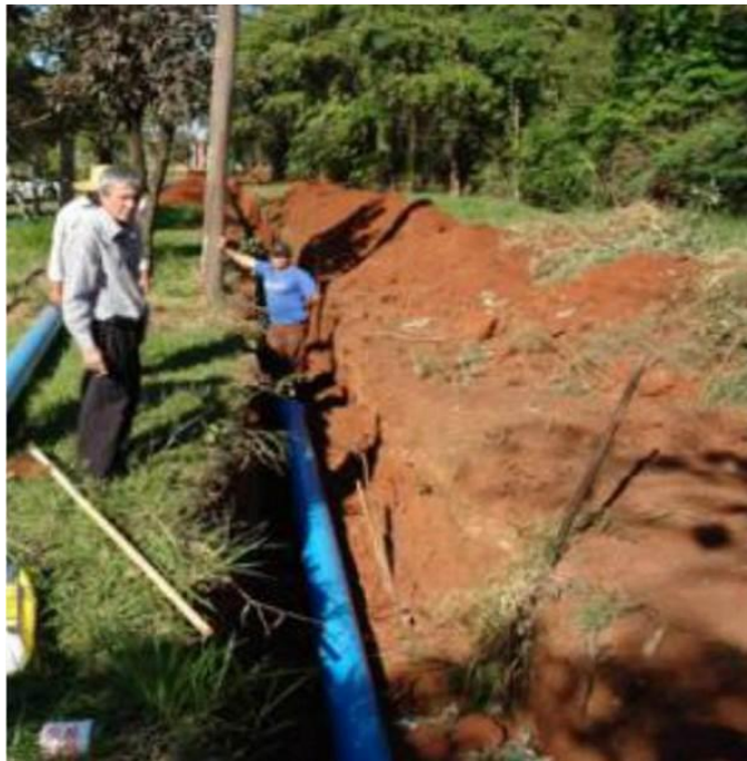
FIGURA 82 – Obra para implantação da rede complementar de água e esgoto do loteamento Morada do Sol
