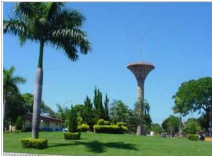
FIGURA 35 – Reservatório elevado, localizado no centro da cidade
