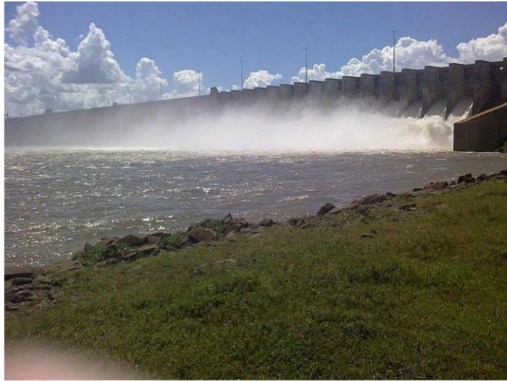
FIGURA 114 – Vista panorâmica: barragem da UHE Ilha Solteira
