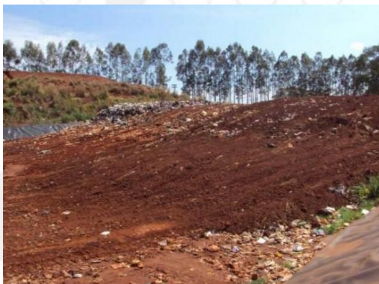
FIGURA 235 – Trincheira em operação
