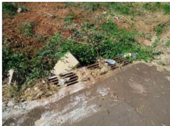
FIGURA 190 – Boca de lobo danificada e obstruída com vegetação e lixo na Rua Jorge de Lima
