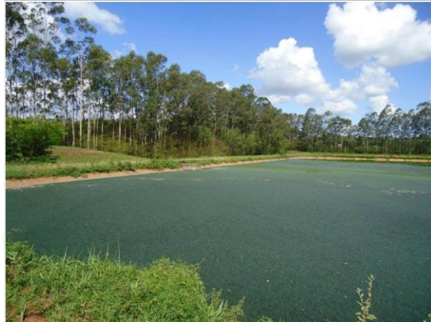
FIGURA 101 – Vista da lagoa facultativa de estabilização 1
