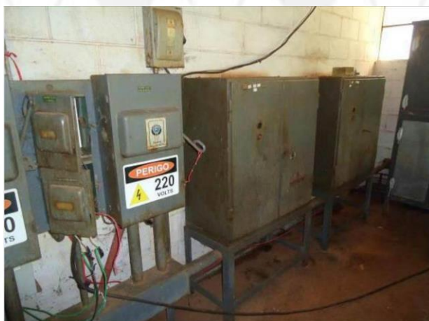
FIGURA 87 – Painel de energização e comando dos conjuntos moto bomba da EEE
