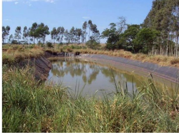
FIGURA 236 – Lagoa de contenção do chorume
