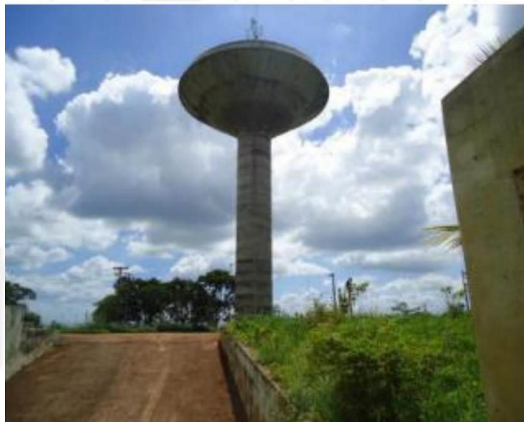
FIGURA 60 – Reservatório elevado do Jardim Aeroporto
