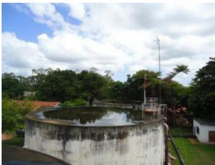
FIGURA 55 – Vista superior dos reservatórios do sistema intermediário
