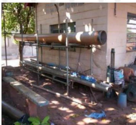
FIGURA 32 – Setor de Manutenção e Serviços, em detalhe edificação de uso geral
