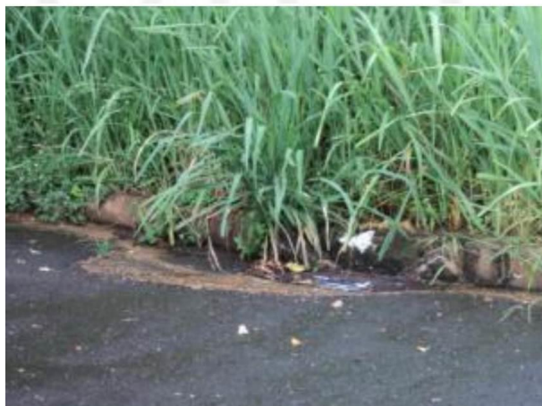
FIGURA 158 – Boca de lobo na Alameda Um
