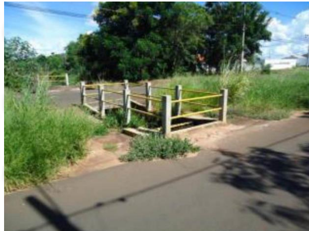
FIGURA 191 – Córrego sob a Avenida Marginal Leste
