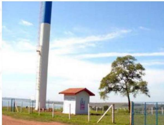
FIGURA 36 – Sistema de captação, tratamento e reservação do bairro Recanto das Águas
