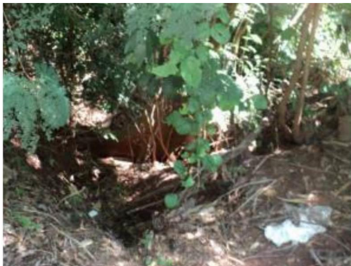
FIGURA 145 – Lançamento ao lado da Avenida Continental em fundo de vale. Próximo ao parque da Mantiqueira
