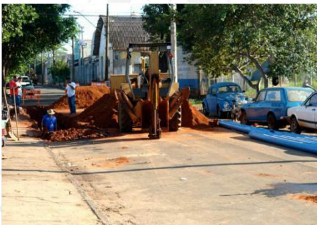
FIGURA 84 – Obra de reestruturação de 50 metros de redes de abastecimento de água e coleta de esgoto na Alameda Amazônia
