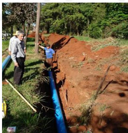
FIGURA 120 – Obra para implantação da rede complementar de água e esgoto do loteamento Jd. Morada do Sol
