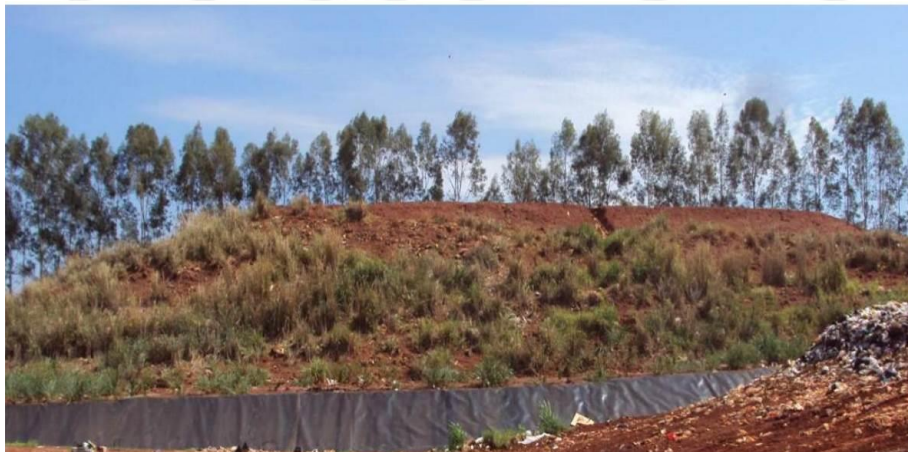
FIGURA 241 – Trincheira encerrada sem recuperação
