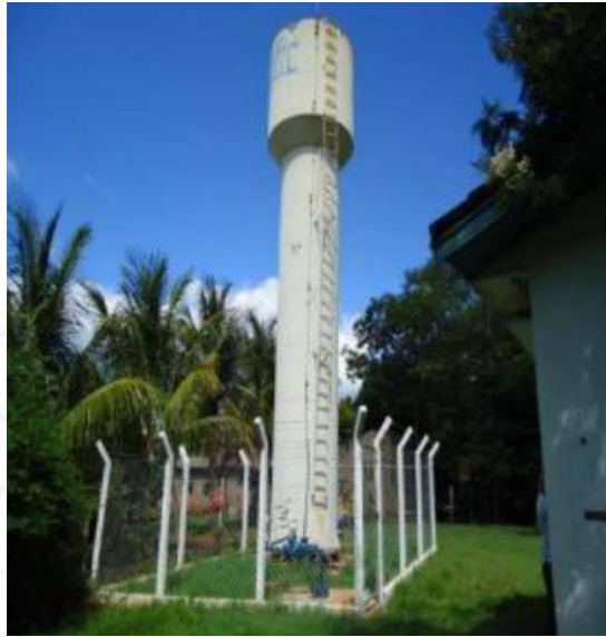
FIGURA 75 – Reservatório de água potável no sistema Lote 76
