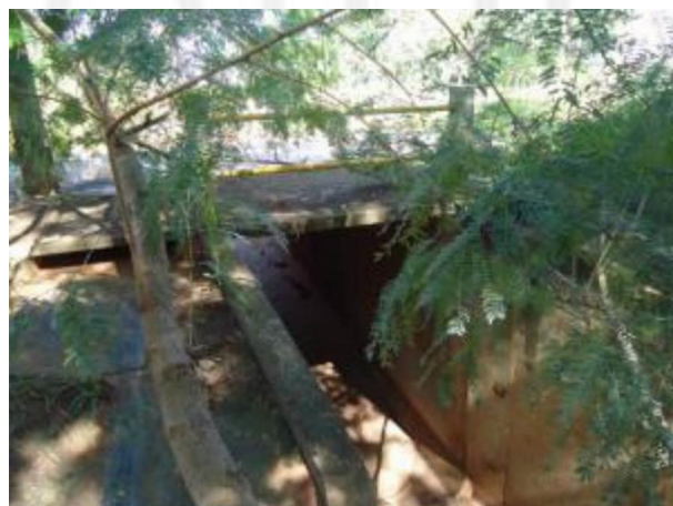
FIGURA 192 – Travessia construída sobre córrego
