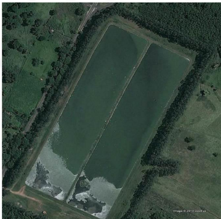
FIGURA 108 – Vista de satélite das lagoas facultativas, apontamento de bancos de areia
