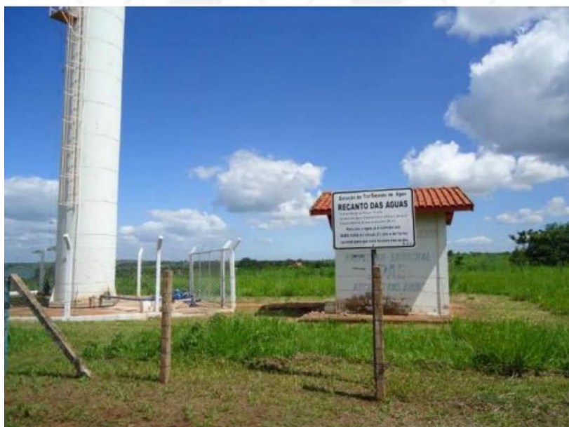
FIGURA 63 – Instalações do sistema Recanto das Águas
