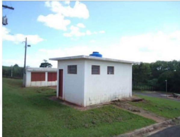
FIGURA 97 – Instalações da EEE 4
