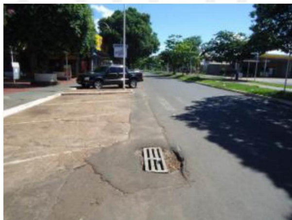
FIGURA 170 – Implantação recente (2013) de boca de lobo na Avenida Brasil Sul
