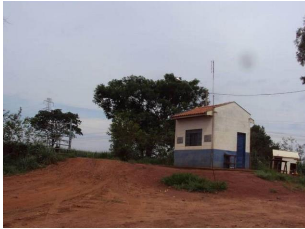
FIGURA 242 – Guarita para controle de acesso
