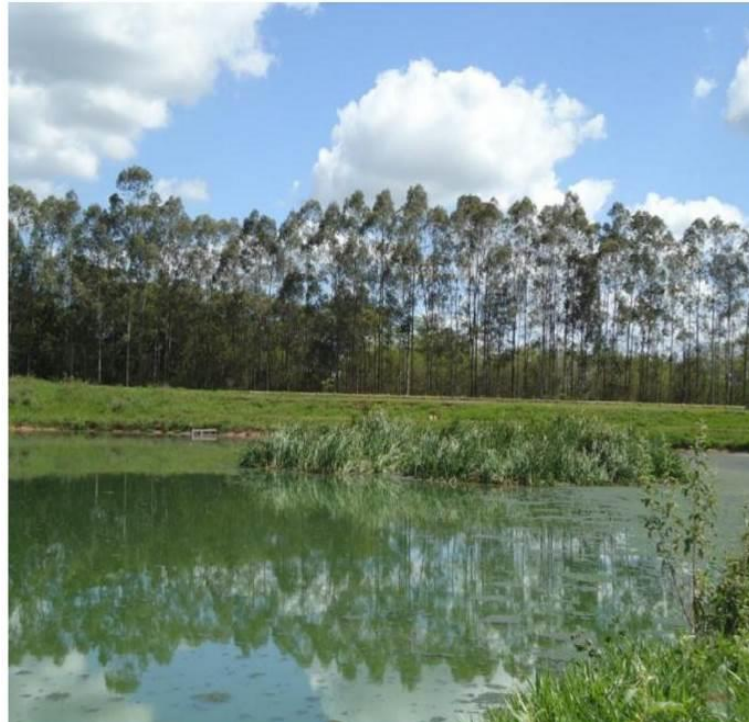
FIGURA 109 – Vista da lagoa facultativa 2, bancos de areia e formação de vegetação
