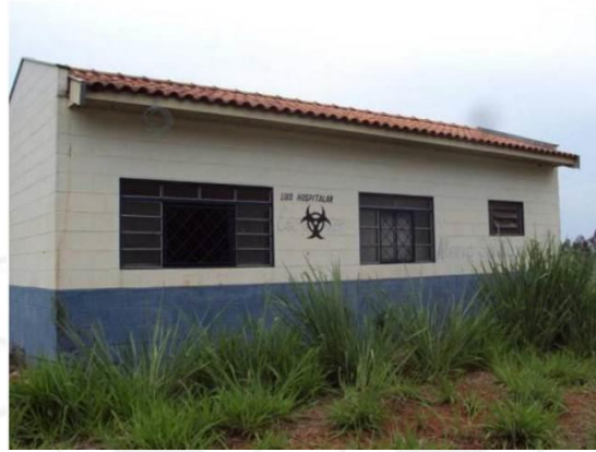
FIGURA 219 - Local de recepção dos resíduos de serviços de saúde no aterro sanitário
