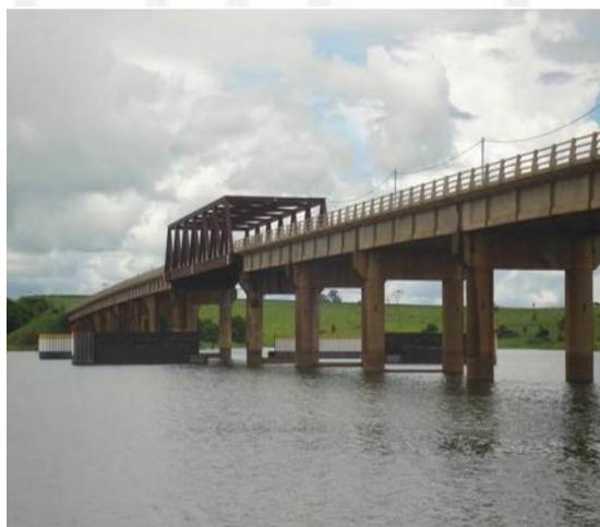
FIGURA 20 – Vista panorâmica da ponte sobre o Rio São José dos Dourados
