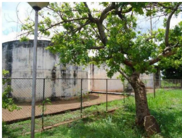
FIGURA 54 – Reservatórios elevados do sistema intermediário de adução
