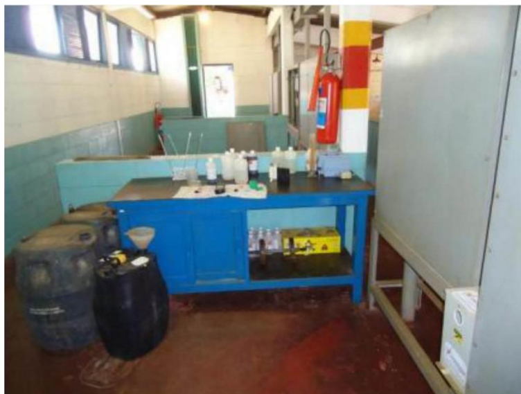
FIGURA 47 – Infraestrutura e local de análises diárias para controle de potabilidade de água no Sistema de Recalque 3
