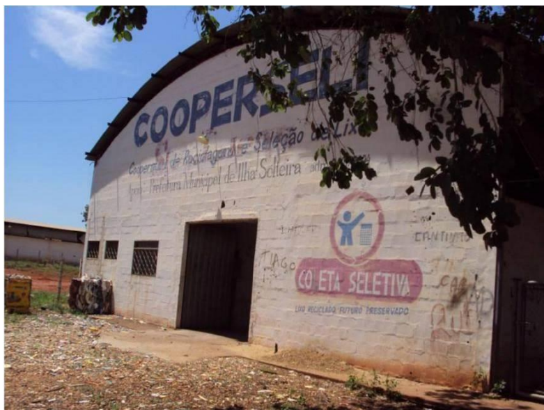
FIGURA 203 – Galpão da coleta seletiva
