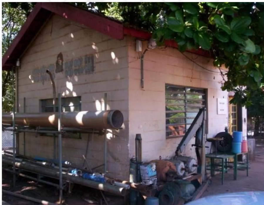
FIGURA 119 – Instalações do Setor de Manutenção e Serviços de Ilha Solteira
