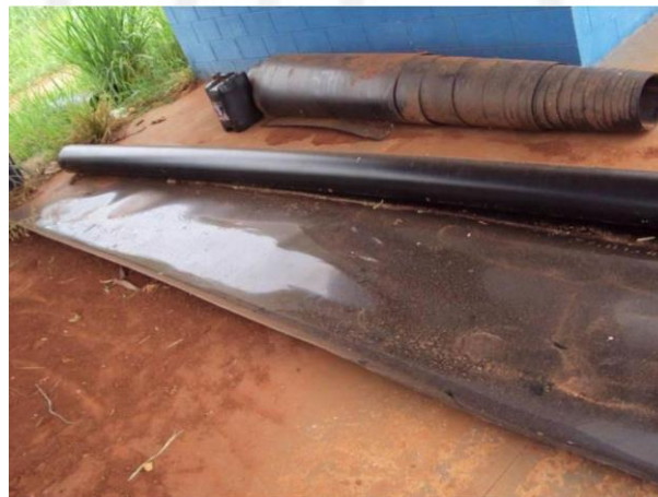
FIGURA 244 – Manta de PEAD para adequação da nova trincheira
