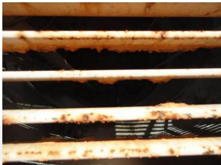
FIGURA 95 – Grades do poço de sucção da EEE5
