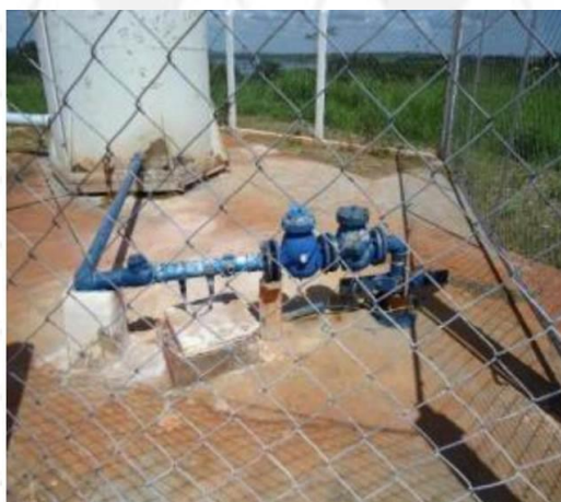
FIGURA 64 – Conjunto motobomba de captação de água do poço no Recanto das Águas
