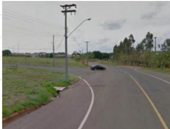
FIGURA 161 – Pontos de captação de águas pluviais na esquina da Avenida Atlântica com Alameda Santa Catarina
