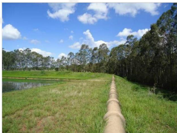
FIGURA 102 – Emissário: tubulação de concreto com diâmetro de 1.000 mm
