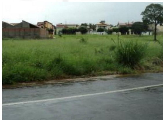
FIGURA 162 – Av. Atlântica, águas escoando pela pavimentação devido à canaleta obstruída
