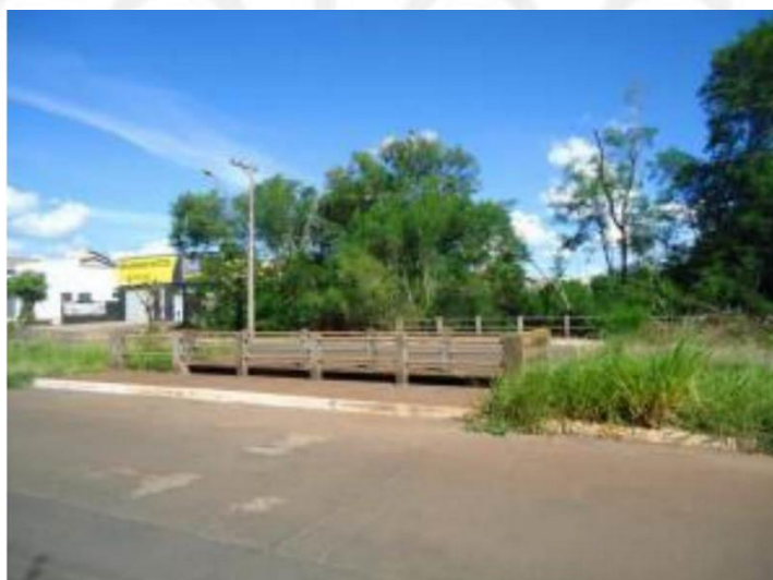
FIGURA 181 – Avenida Quinze de Novembro: viaduto sobre o “córrego sem nome”
