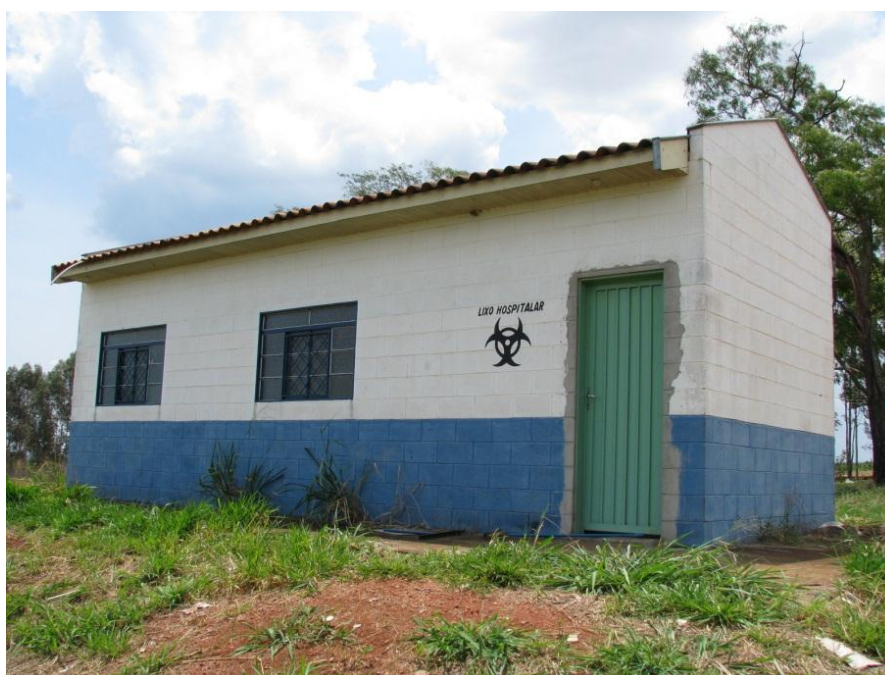
Figura 52 – Foto do local onde são acondicionados provisoriamente os resíduos dos serviços de saúde dentro das dependências do Aterro Sanitário.
