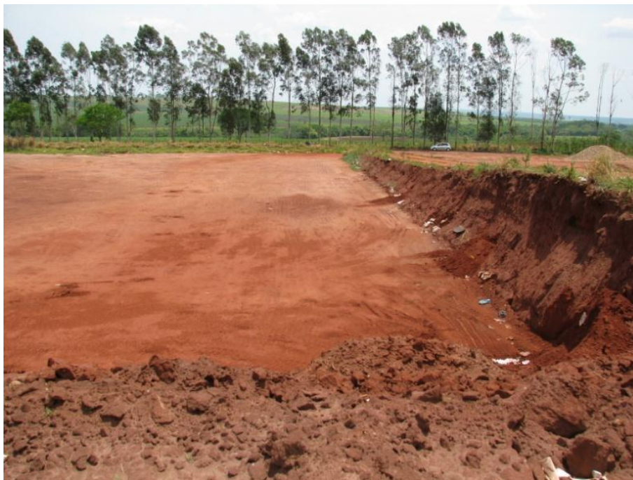
Figura 23 – Fotografia do local da futura célula já em construção.
