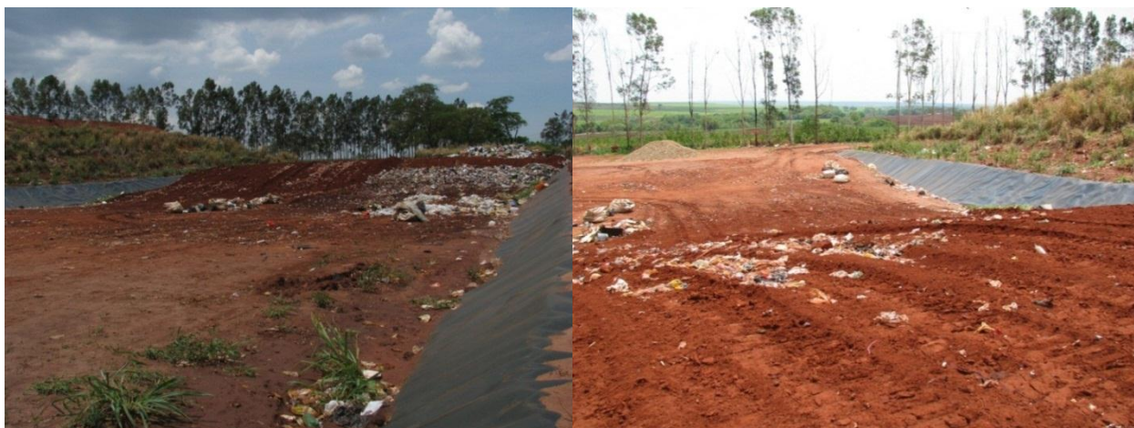
Figura 22 – Fotografia da atual célula utilizada para a disposição final dos resíduos domiciliares/comercial.
