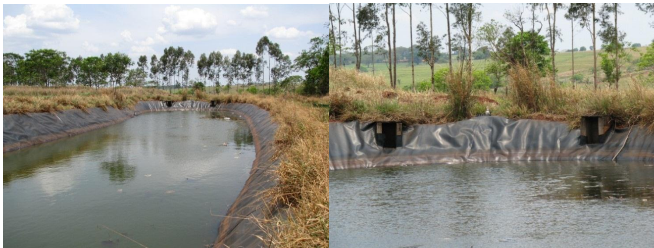
Figura 21 – Fotografia da lagoa de Chorume do Aterro Sanitário.
