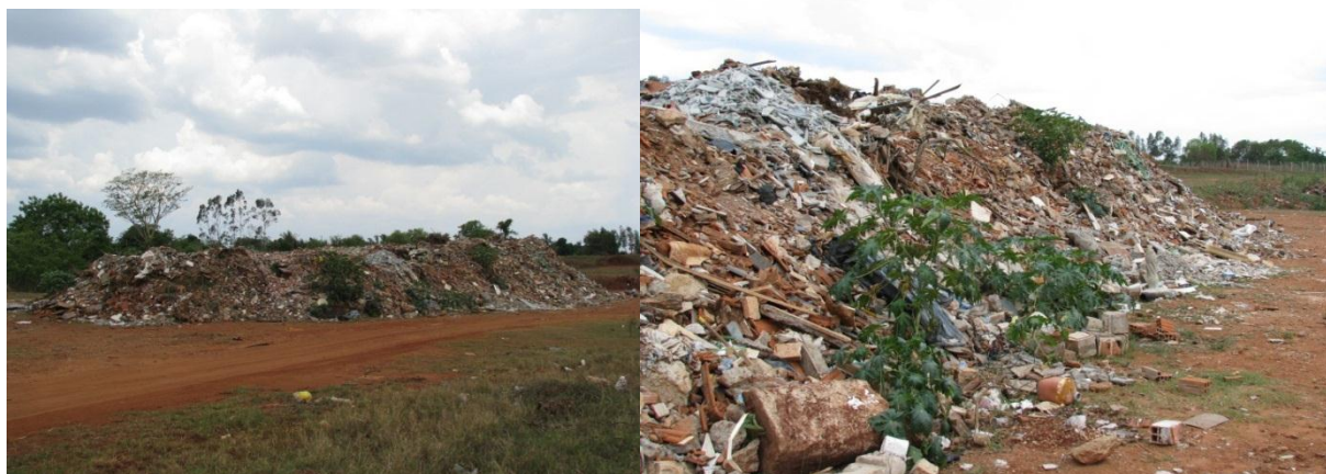
Figura 55 – Fotos da vista geral do local de disposição final dos resíduos.
