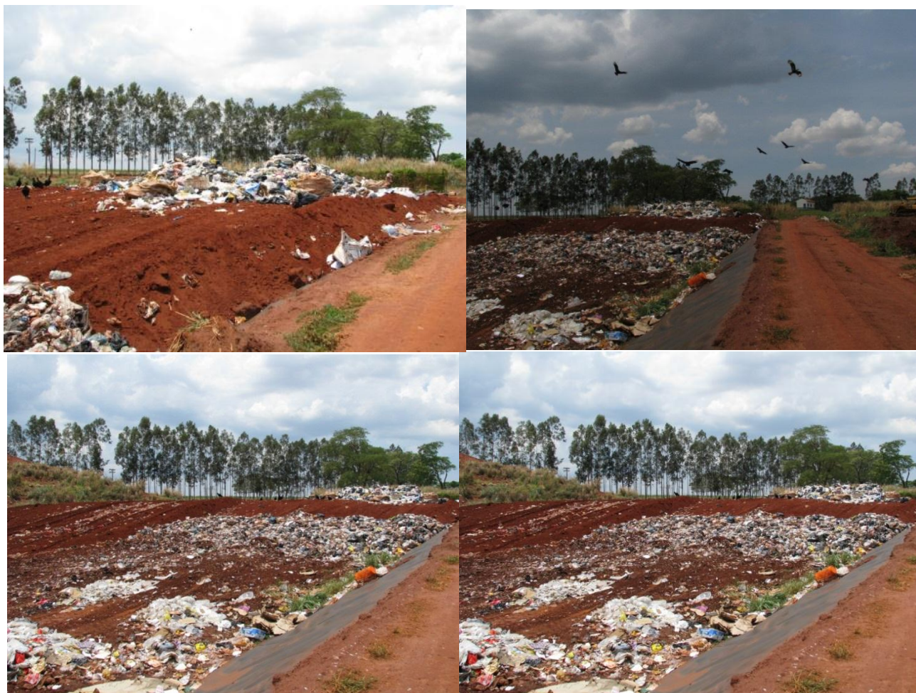
Figura 26 – Fotografia da vista geral do Aterro Sanitário, destaque para os resíduos descobertos e para a presença de aves no local.
