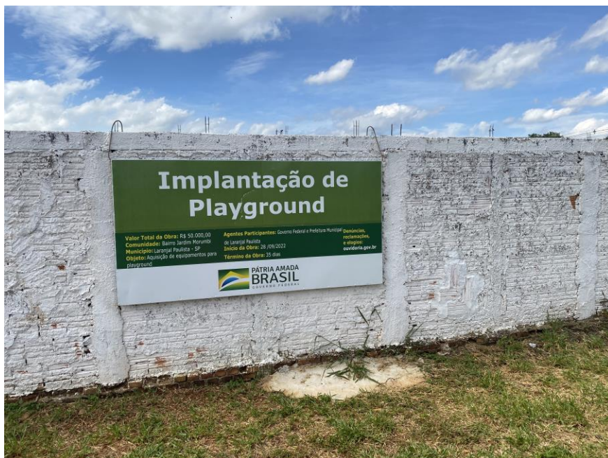
Foto 3. Placa da obra
