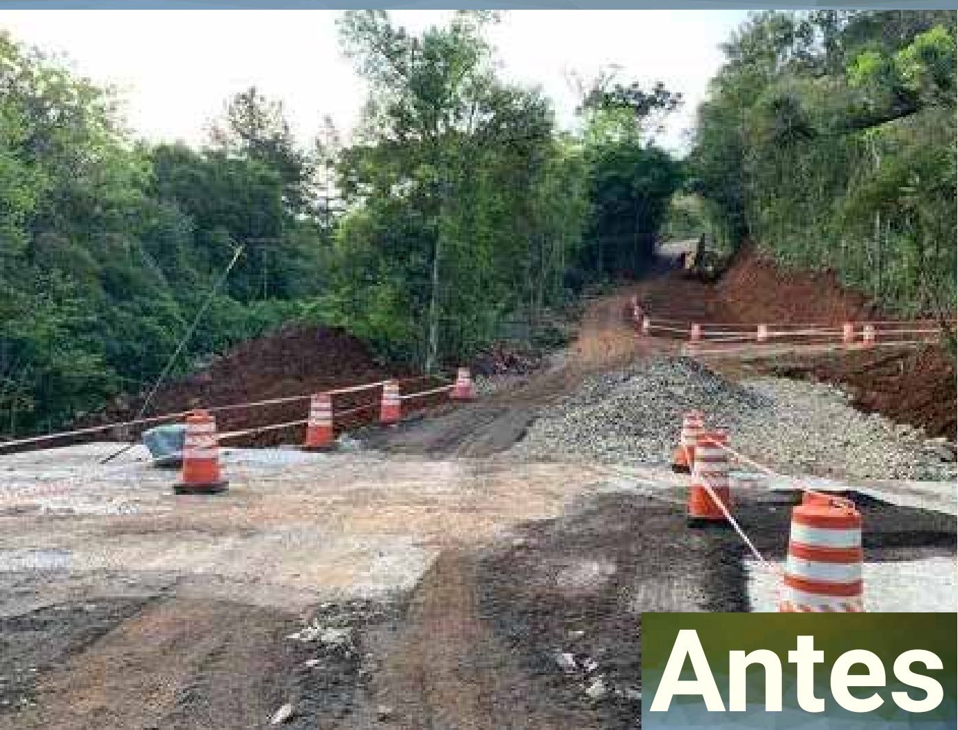
Asfaltamento na Linha 28.
