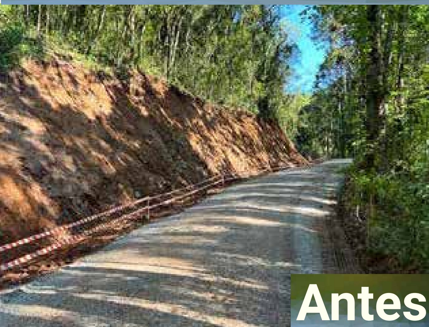
Asfaltamento Linha Furna.
