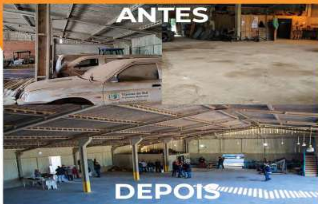
Reforma do Pátio de Máquinas
